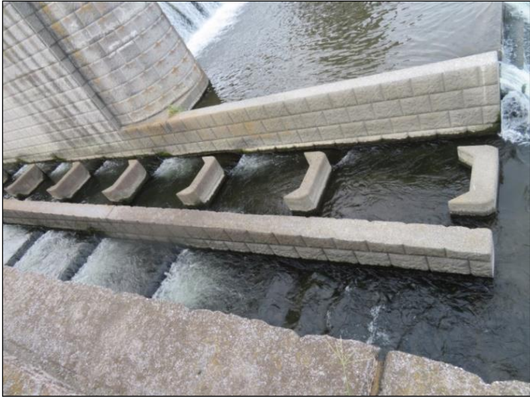
圖 50 多摩川宿河原堰堤魚道
