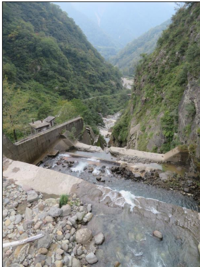
圖 36 白岩砂防堰堤高差 108 公尺
