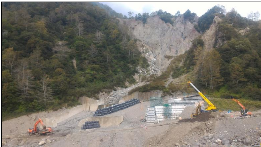
圖 40 防砂壩清除浮石施工情形
