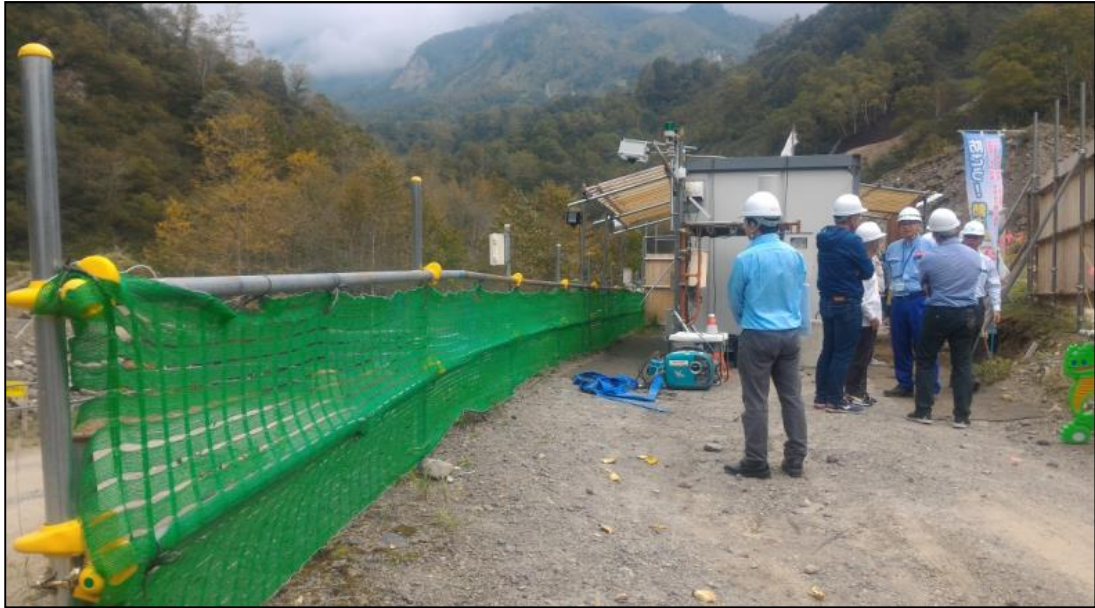
圖 43 職業安全衛生設備-護欄照片
