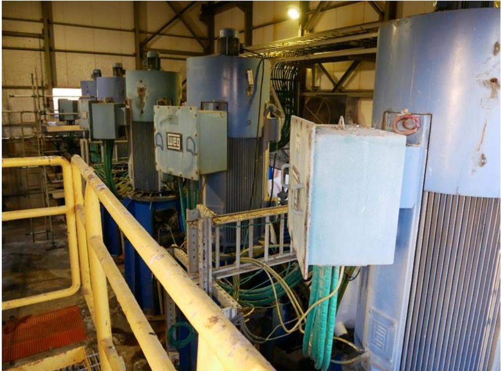
圖 3-4 Hadera 海水淡化廠取水泵
