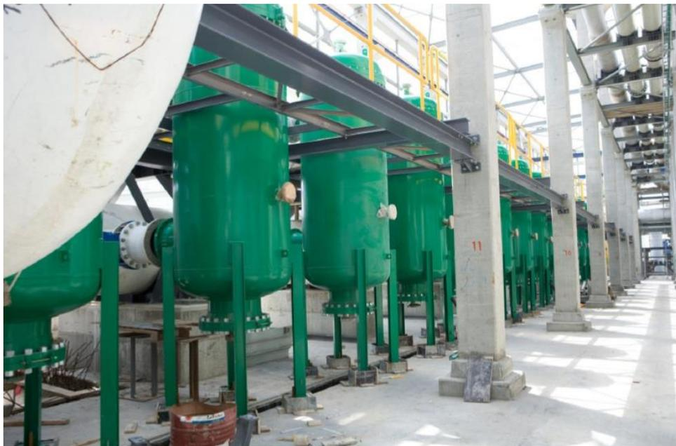
圖 3-5 20 micron 過濾設備
