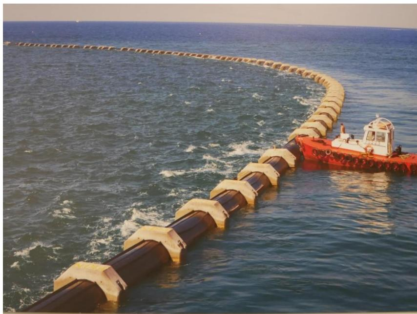
圖 3-3 Hadera 海水淡化廠海洋取水管
