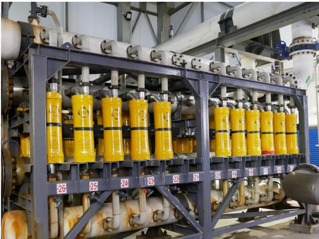
圖 3-8 Hadera 海水淡化廠能源回收系統
