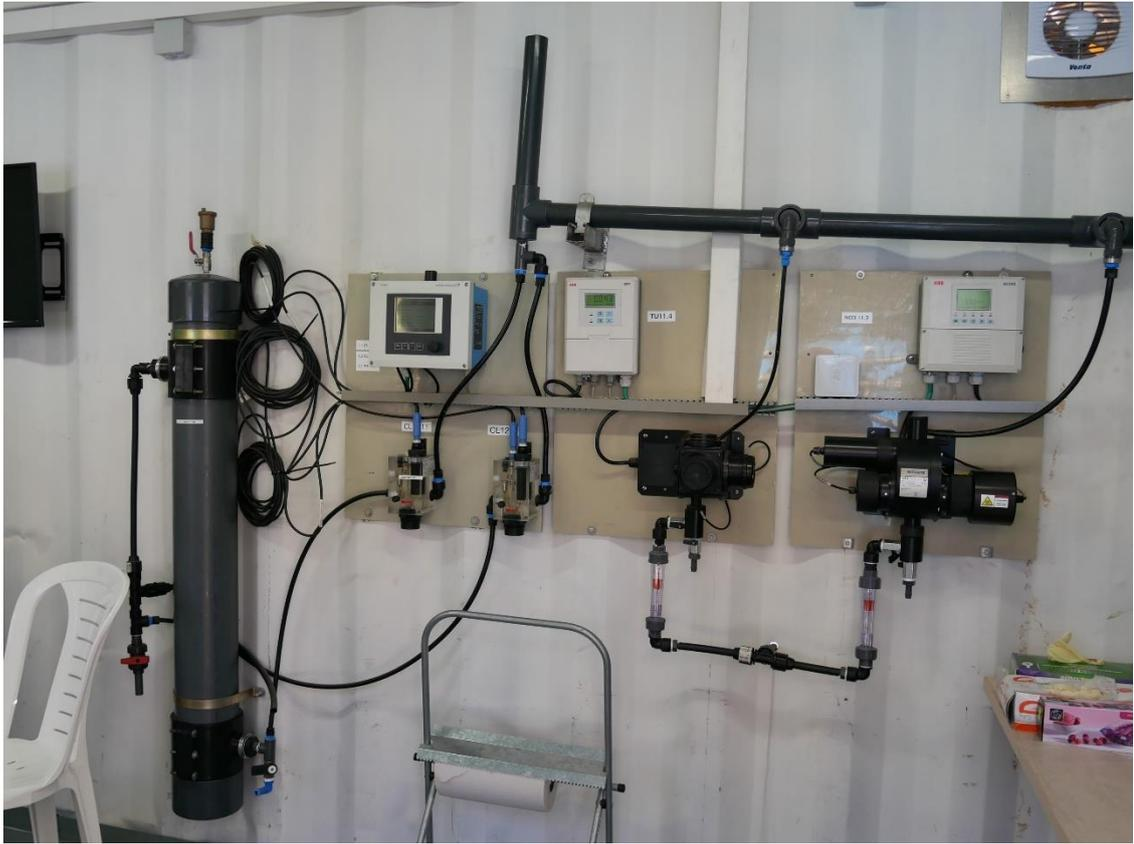
圖 4-3 ToxSorb 公司水處理設備線上水質監測儀器
