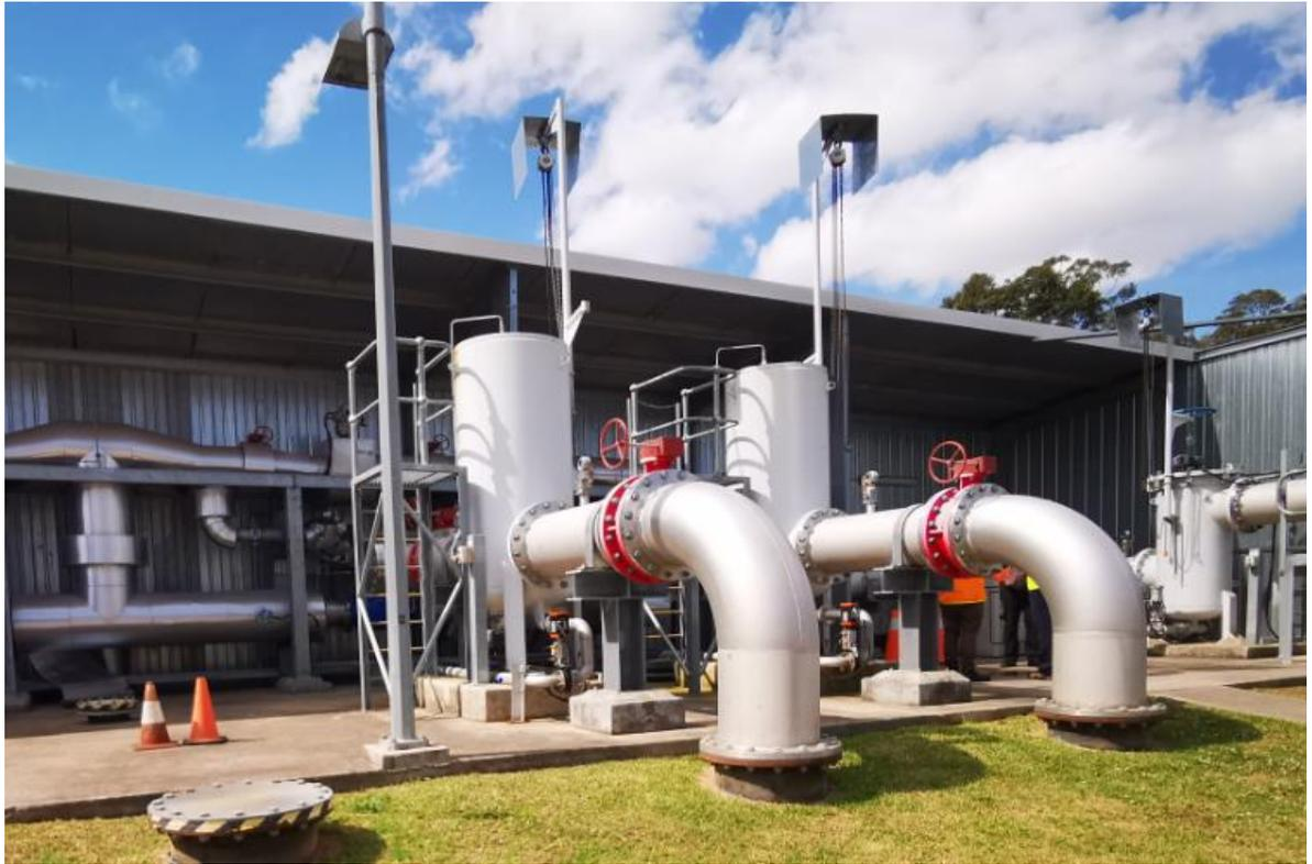
圖 3.7-5 Fairfield 廠進流泵浦及管線設施裝設過濾器
