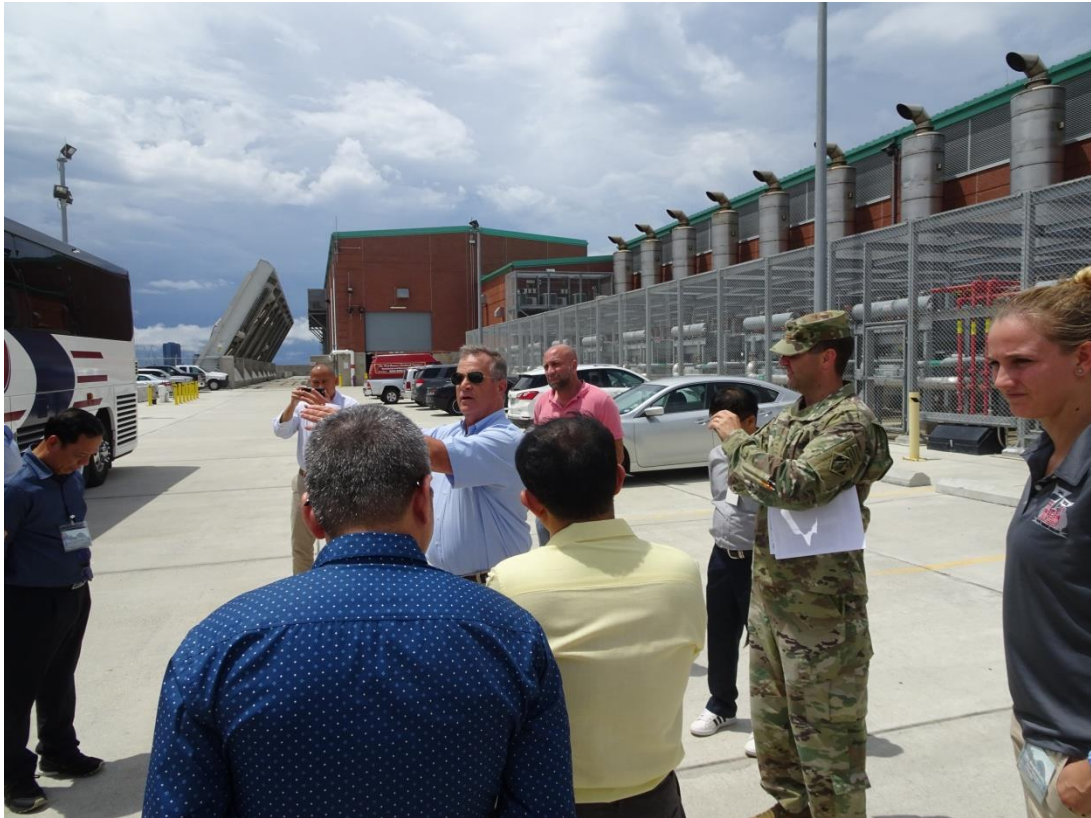
照片 2-8 第 17 街運河抽水站
