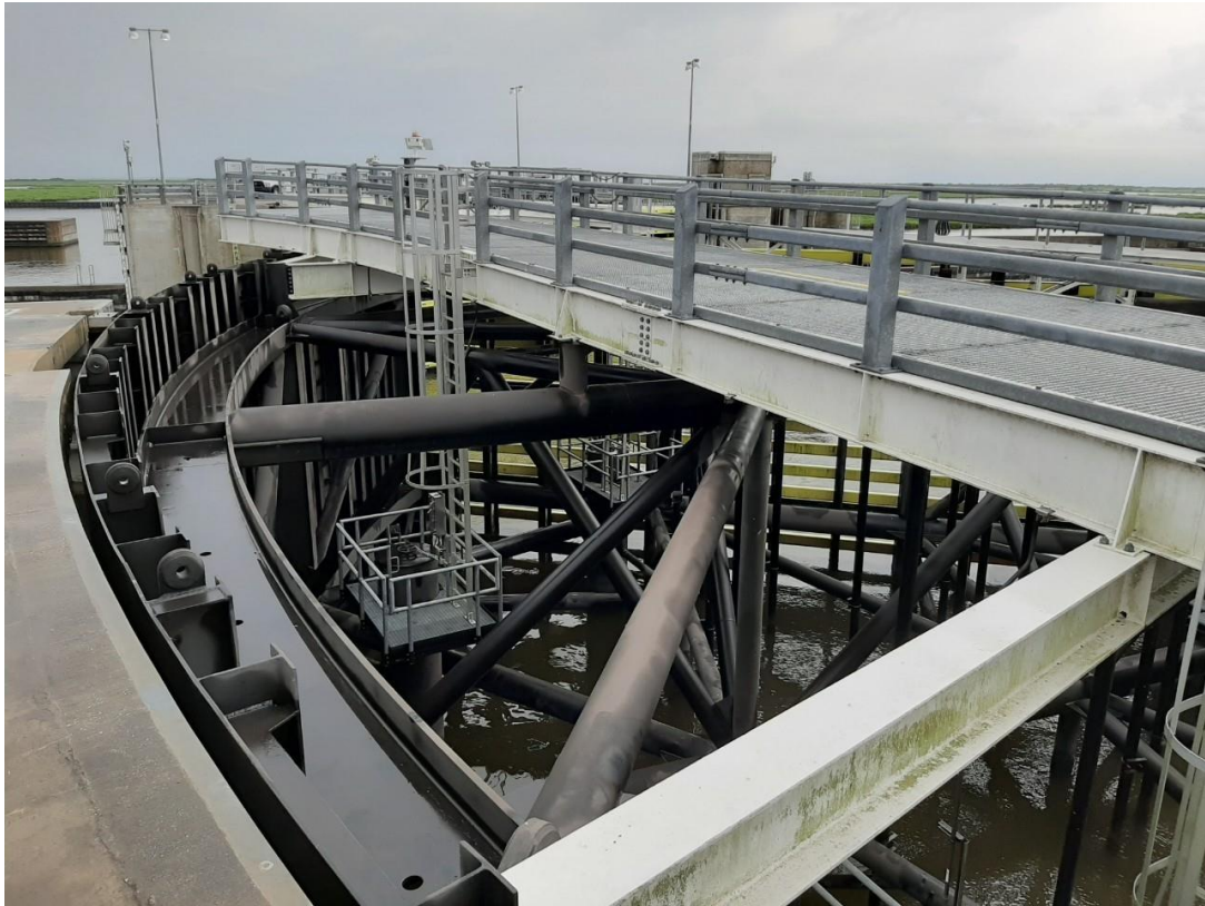
照片 2-5 扇形閘門內部
