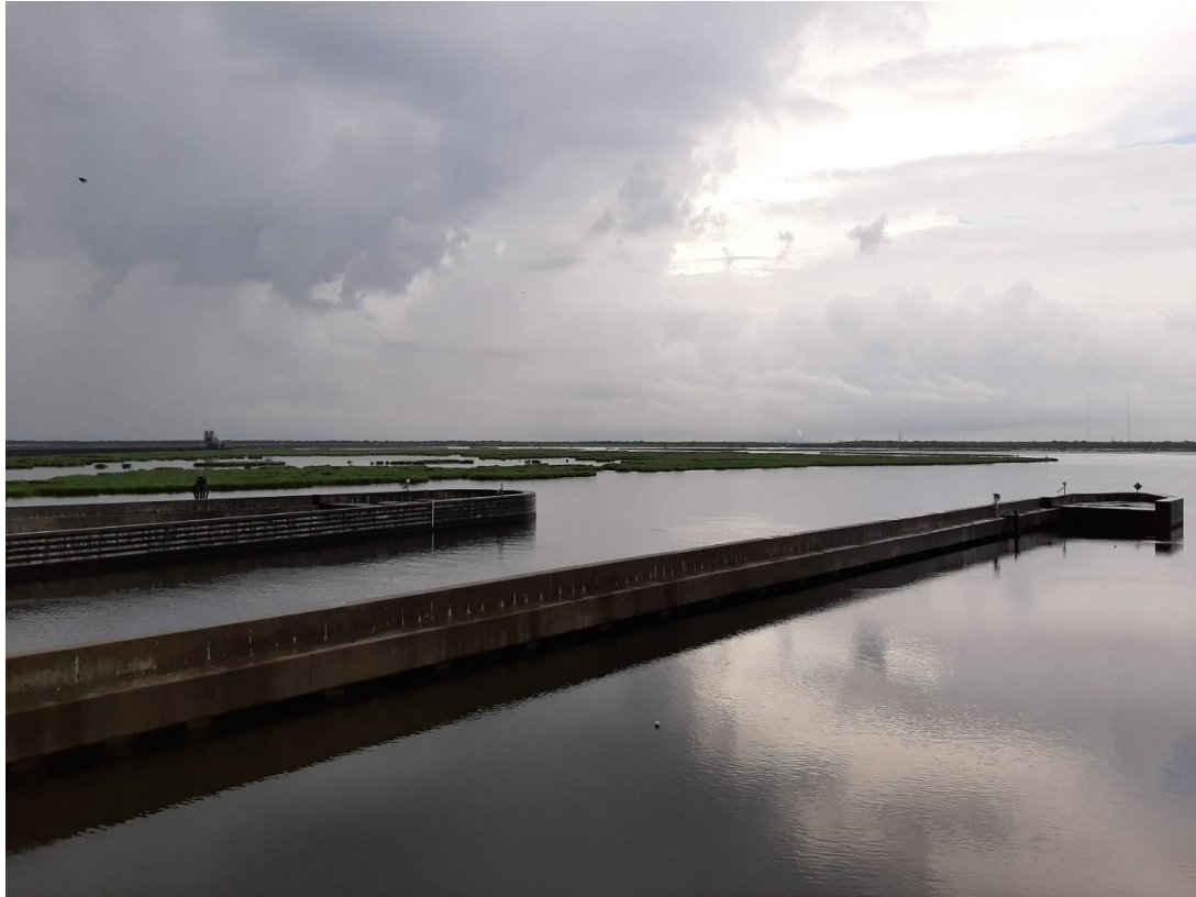
照片 2-7 防潮閘門上游(IHNC)面
