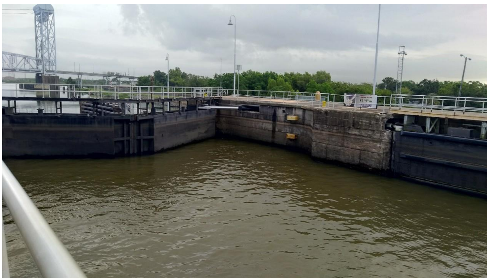
照片 2-1 內港航運運河閘門
