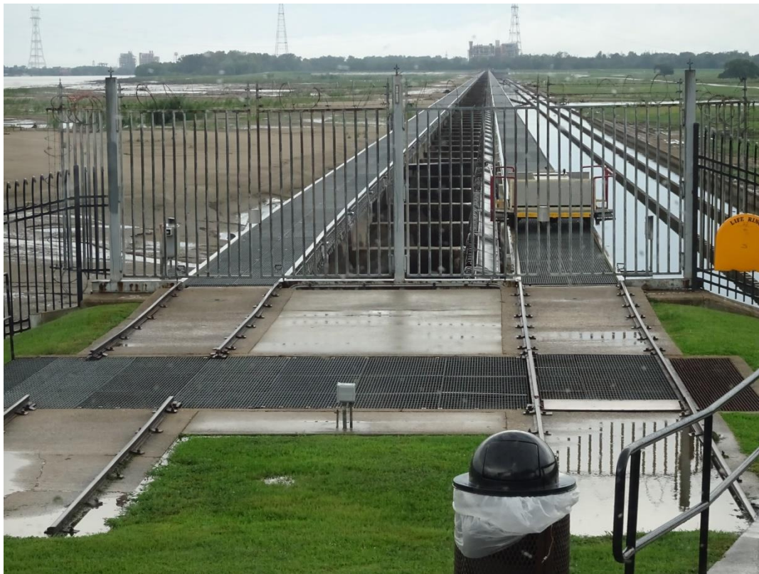
照片 2-11 邦卡萊溢洪道頂面
