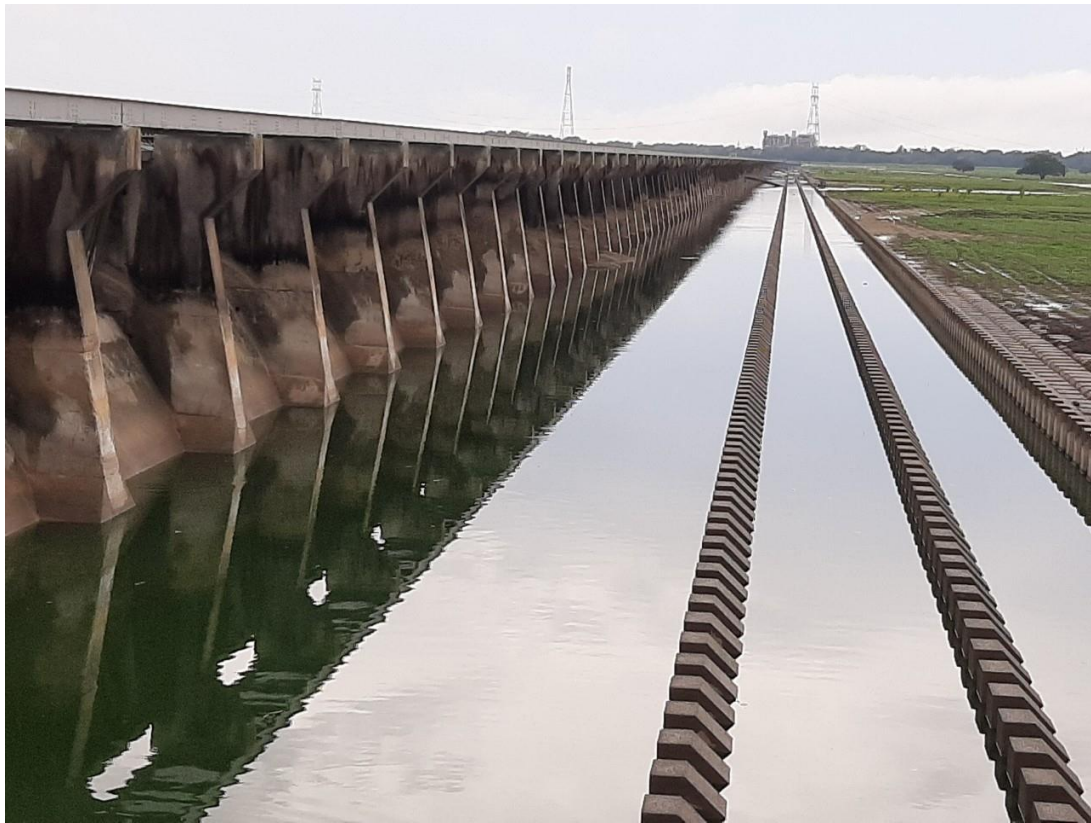
照片 2-12 邦卡萊溢洪道側面
