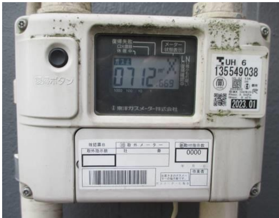
圖 32 安裝於店家之超音波氣量計，目前停用中(東洋計器製造)
