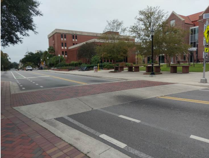
行人穿越道與減速台結合設置
