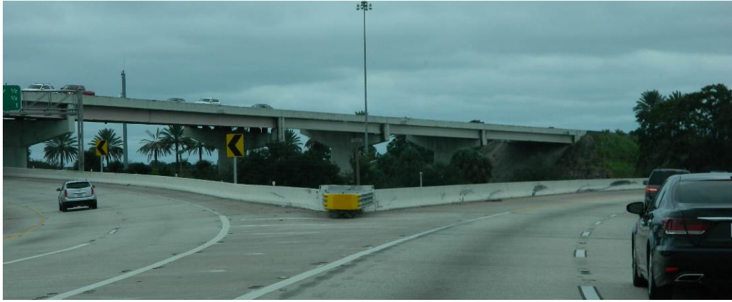
匝道鼻端設置碰撞緩衝設施(二)
