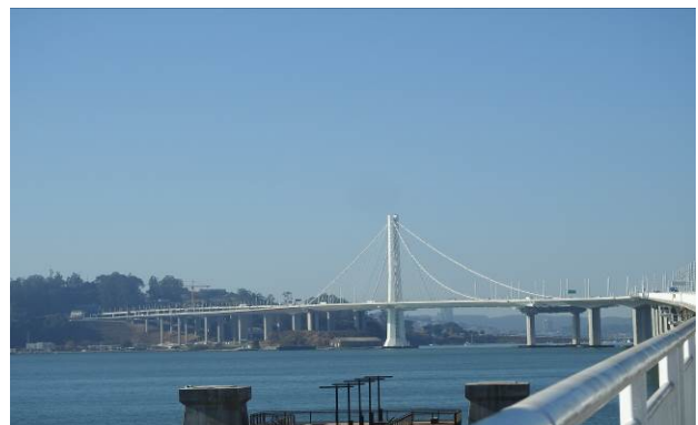
東側新懸索橋
