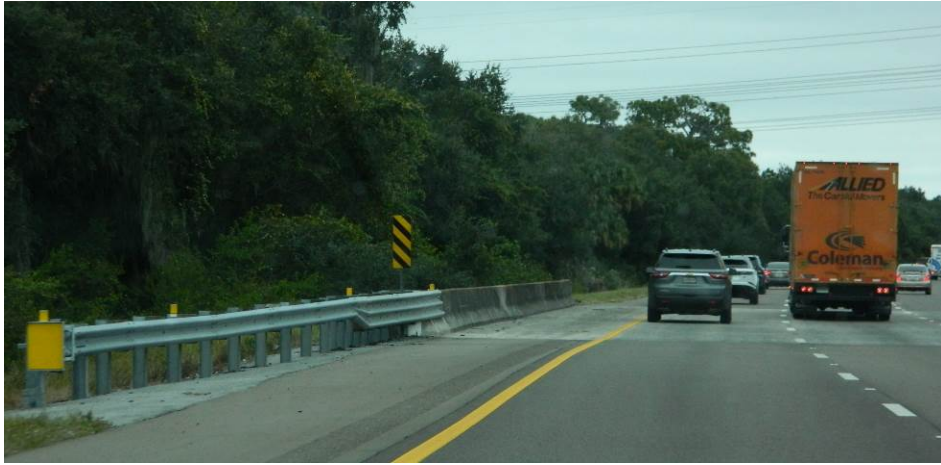
鋼板護欄與混凝土護欄搭接處理(二)
