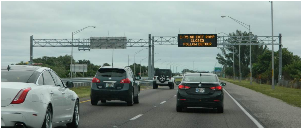
門架設施桿柱設置於護欄外側
