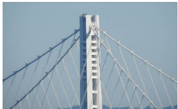
橋塔頂部結構細部
