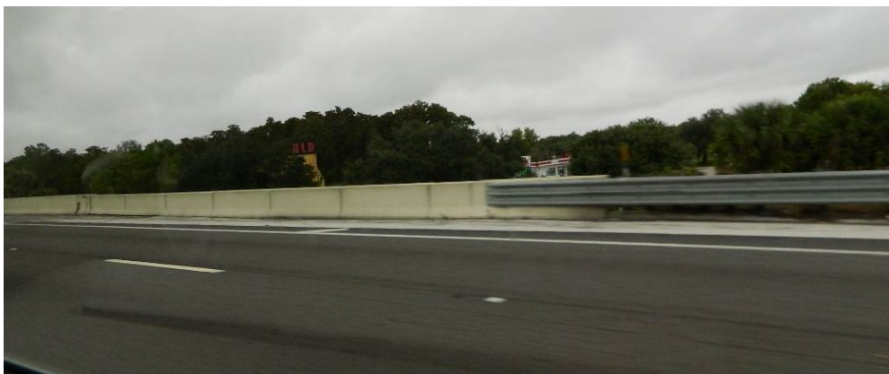
鋼板護欄與混凝土護欄搭接處理(一)
