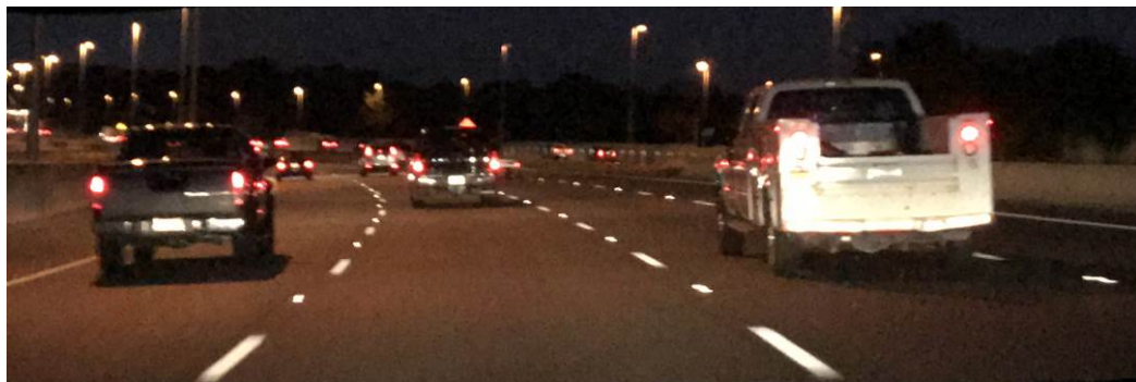
收費公路 Turnpike 反光設施與標線 (二)
