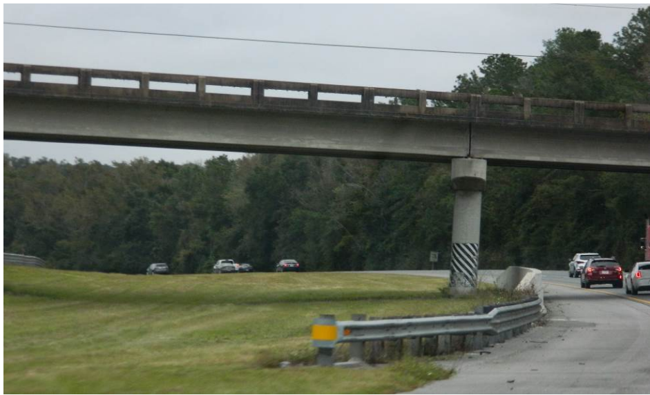
鋼板護欄與混凝土護欄搭接處理(三)
