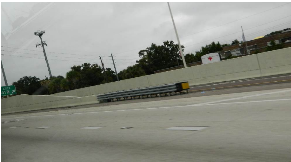
匝道鼻端設置碰撞緩衝設施(一)
