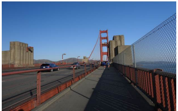
人行及自行車道與欄杆增設安全網
