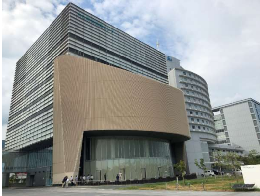
人與防災未來中心-東館
