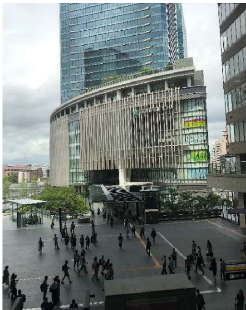
圖4-3 緊臨大阪車站北側之梅北廣場
