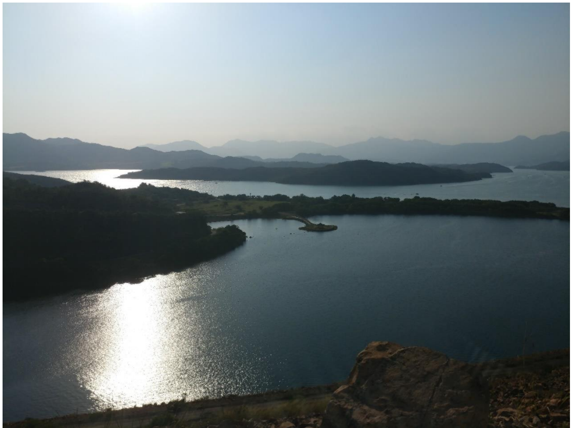
圖 98 萬宜水庫西壩外側(凸出處為月明亭)
