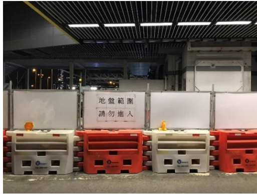
圖 111 港府道路施工採用之可連結式護欄
