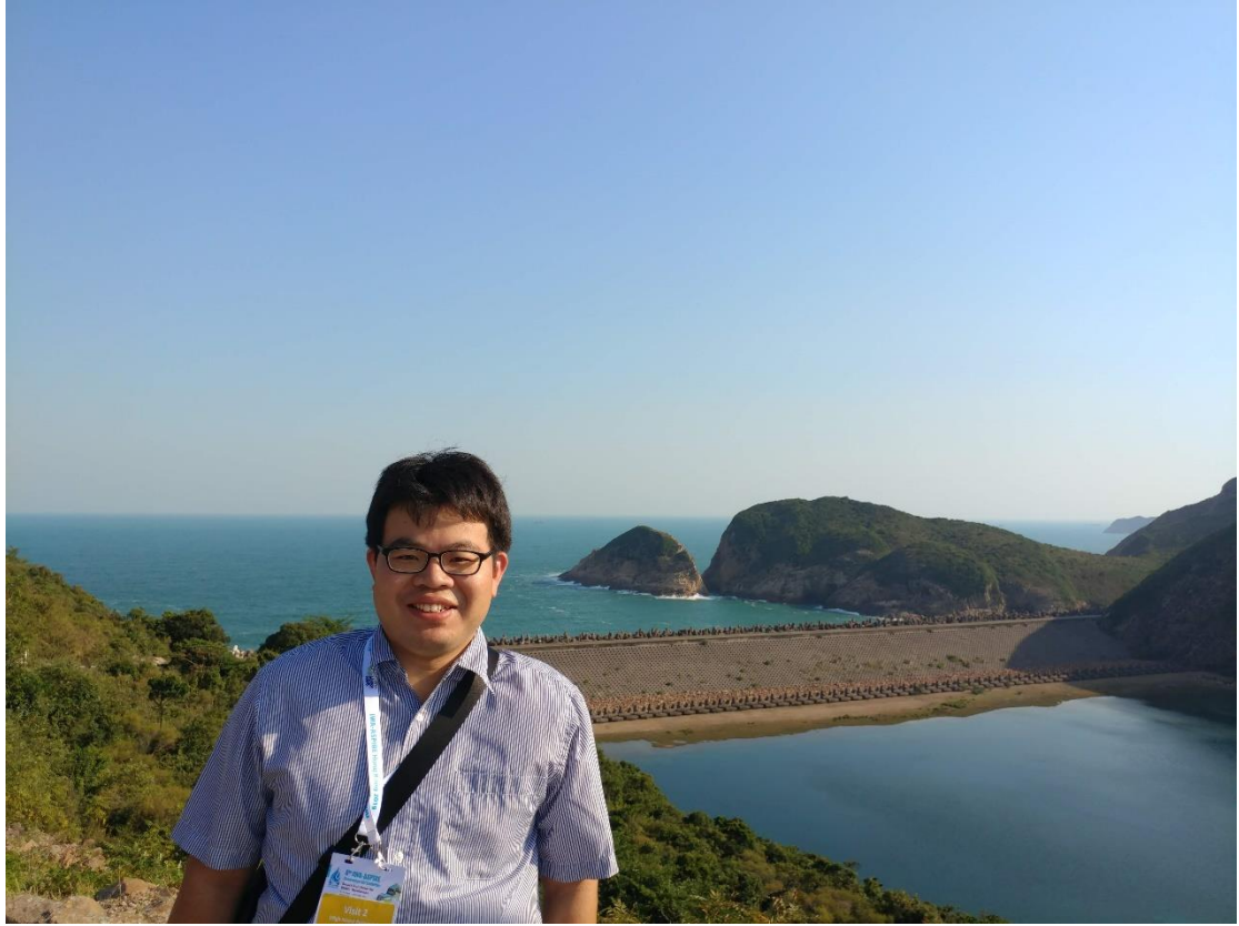
圖 97 萬宜水庫東壩外側防波堤
