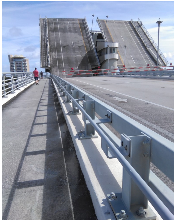
圖 15 美國佛羅里達州勞德岱堡跨海大橋照片
