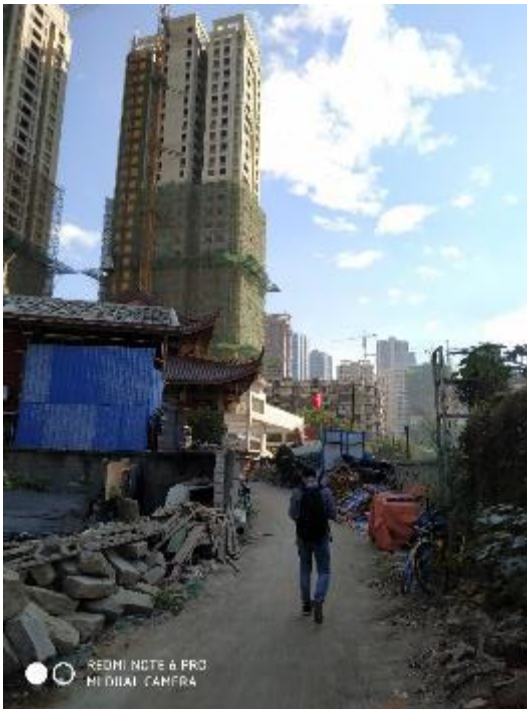
路經施工區域(三)
