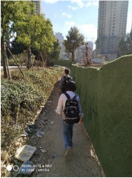
路經施工區域(一)
