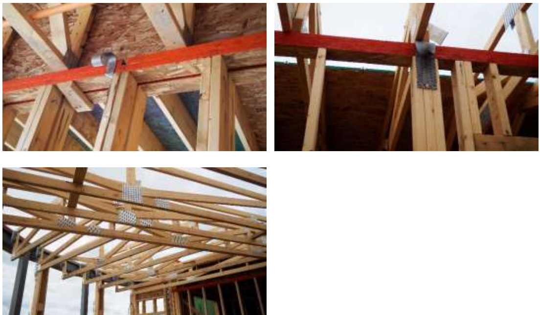
圖表 55 木構造框組壁連接細部
