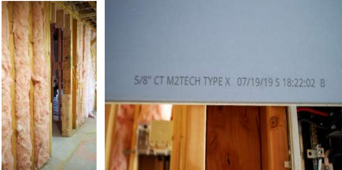
圖表 59 室內牆壁填塞防火棉與 TYPE X 石膏板
