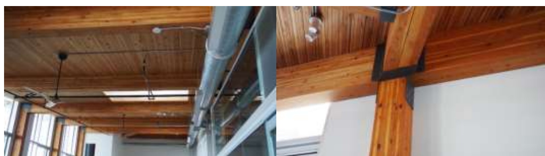
圖表 45 框架梁柱系統透過鋼製連接器
