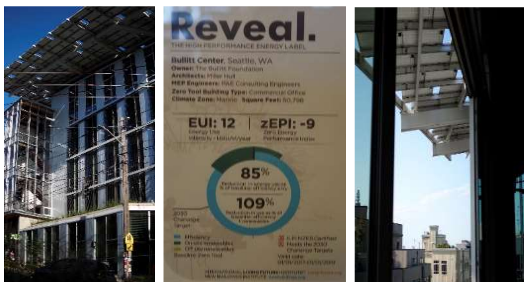
圖表 43 Bullitt Center 深出挑之太陽光電屋簷&能源標示
