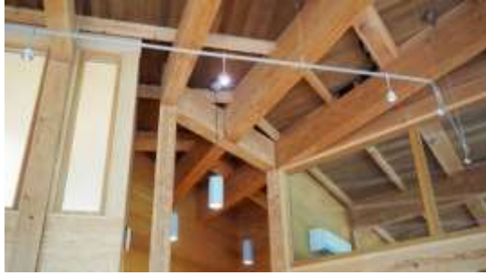
圖表 32 膠合樑與屋頂板材處理
