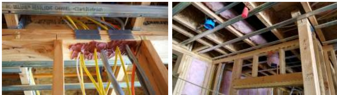
圖表 60 貫穿管線填塞防火泥及防火棉等材料
