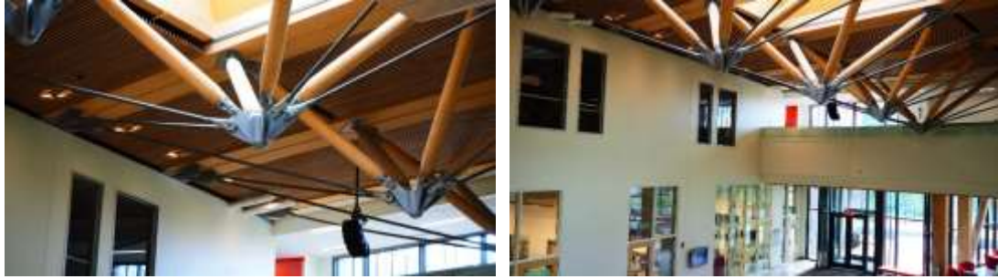
圖表 36 木材與鋼桁架及鋼索組成之屋頂系統
