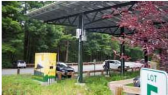
圖表 33 停車場屋頂設置大型太陽能發電
