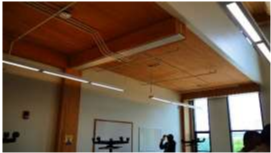
圖表 39 木構造樑與鋼構及混凝土樓板結合
