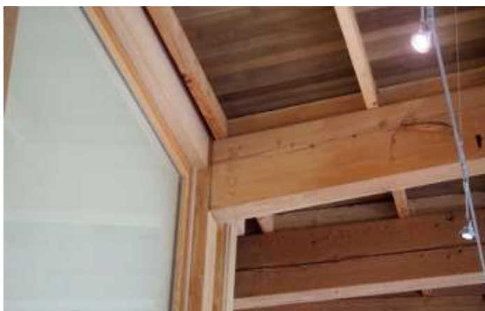
圖表 31 展覽空間採用膠合樑柱系統與屋頂板材處理&LEED 標章
