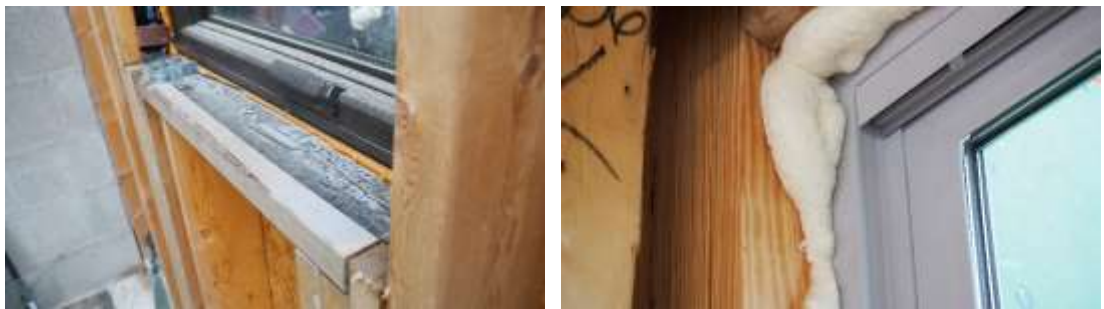
圖表 54 外牆開窗防水施工細部
