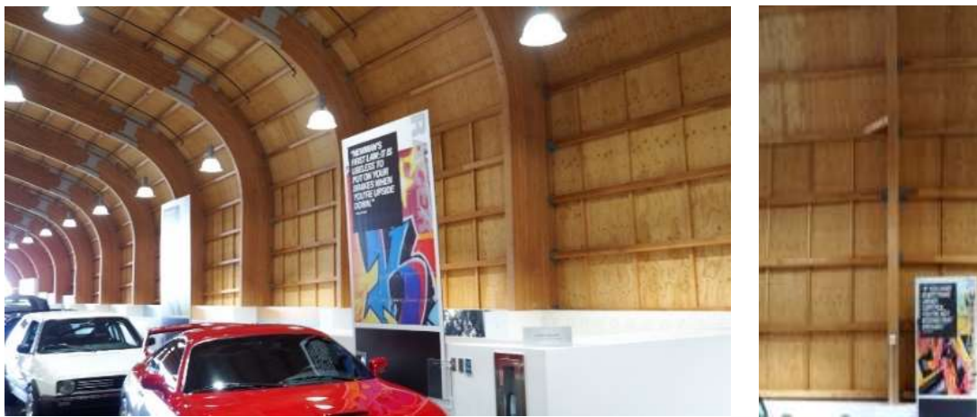
圖表 63 膠合木框架和膠合木條構成之彎曲屋頂，具精準的計算與施工
