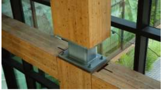
圖表 38 木構造梁柱接合之金屬連接器
