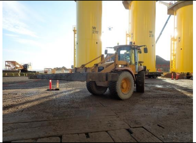
D. 整地-增加平穩度及地板強度
