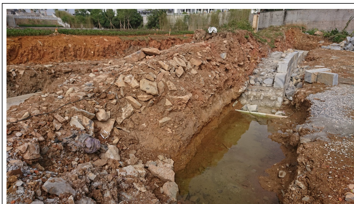
圖 14 太平府故城城牆修復現況
