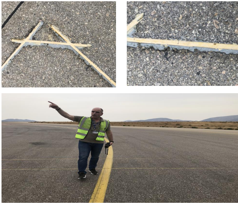
圖 13：道面切割縫隙修補
