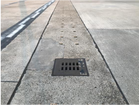
圖 14：松山機場停機坪排水溝
