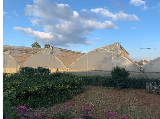
圖 18、Loc Trol 肥料公司的圓形開側邊天窗式的溫室
