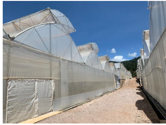
圖 12、林台種苗公司新建 GSP 溫室採取開天窗室自然進氣的溫室
