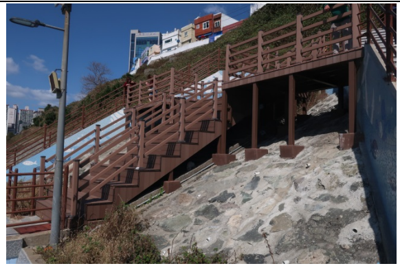
圖 64、木棧階梯搭建在既有水泥步道上
