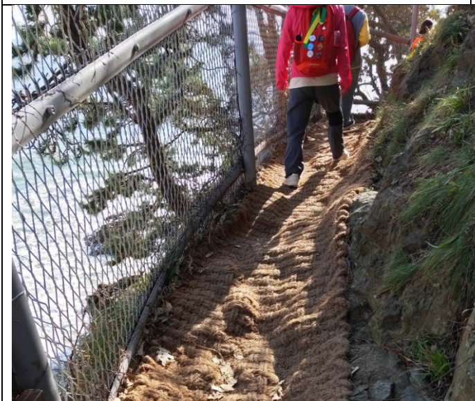
圖26、使用當地材料鋪設
