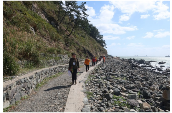
圖 58、步道一隅（碎石、水泥鋪面）
