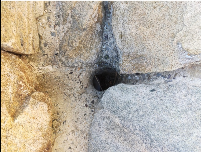
圖30、鋪面設排水孔
