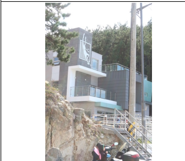
圖 53、提供海女休憩之建物
