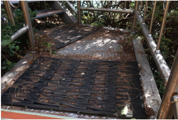
圖 57、運用橡膠、輪胎皮止滑
