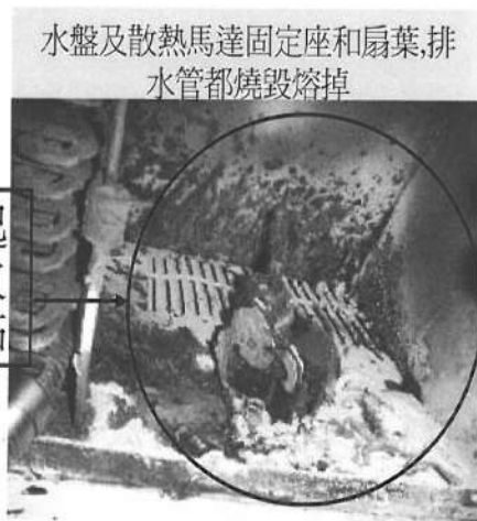
圖 26 第 1 起事故案件起火源 圖 27 第 2 起事故案件起火源
