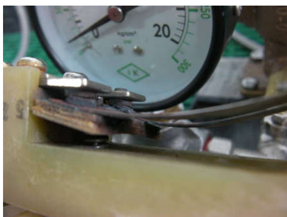
圖 54 水盤開關注水推動接點導通
