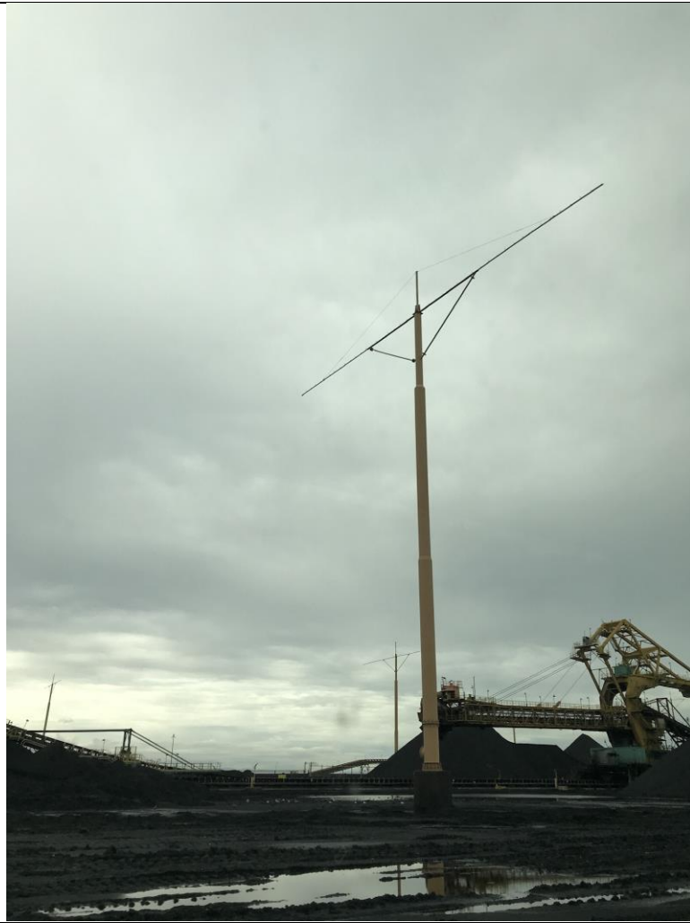
圖4-11：Westshore煤炭專用裝載區域儲煤場灑水塔
