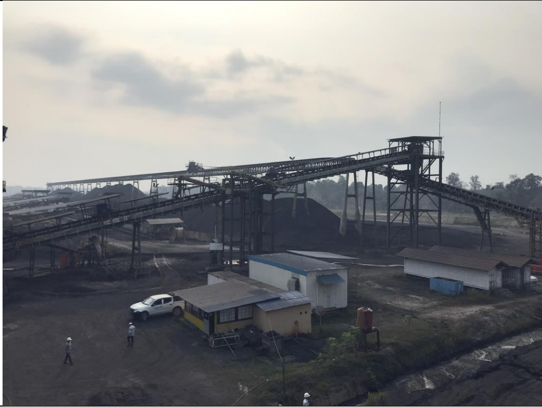
圖1-10：Bharinto煤礦CHPP產品煤儲煤場
