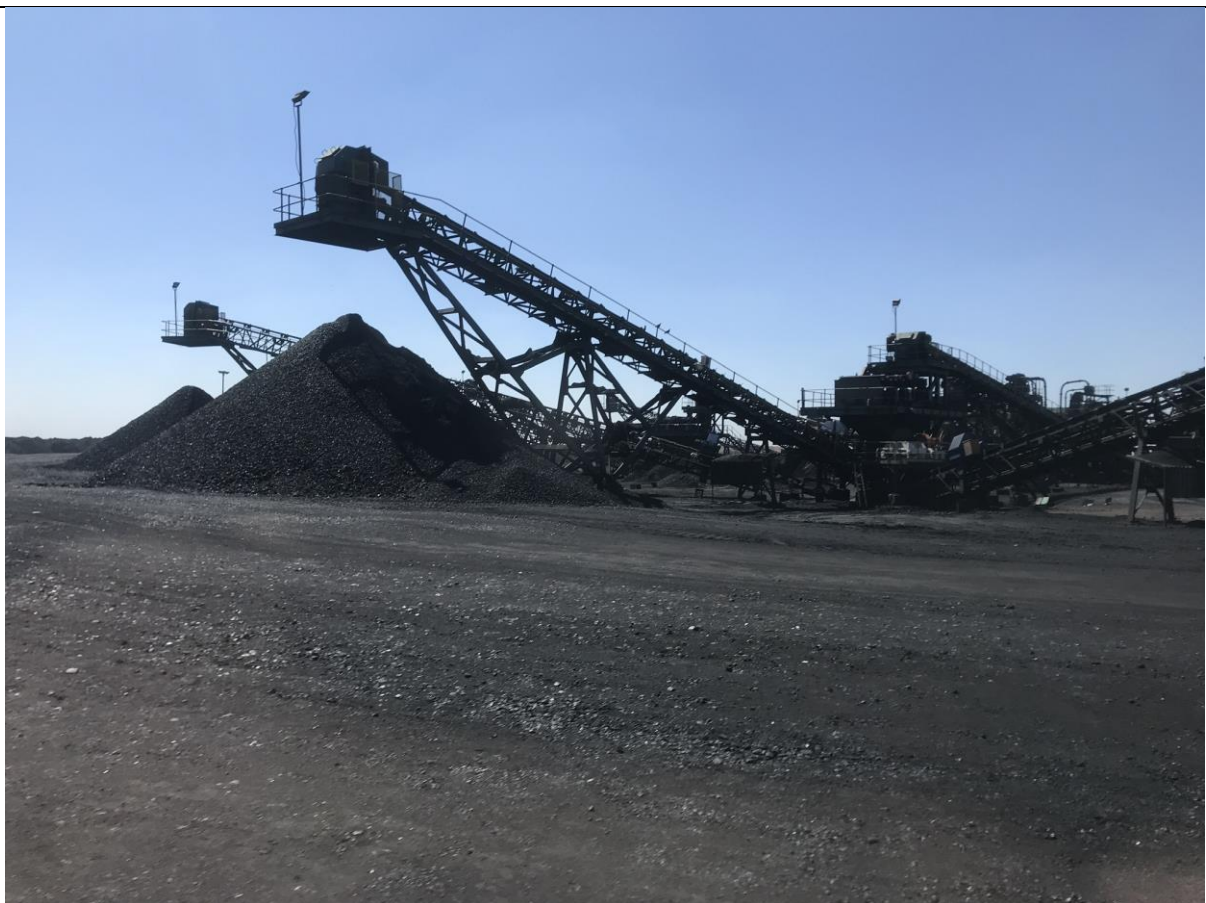
圖3-10：Phalanndwa煤礦CHPP區域洗煤機產品煤皮帶機
