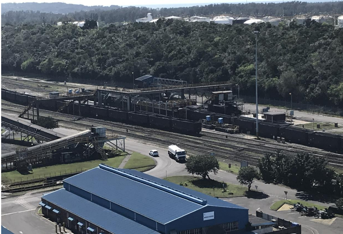
圖3-13：RBCT煤炭專用裝載區域卸煤翻車機
