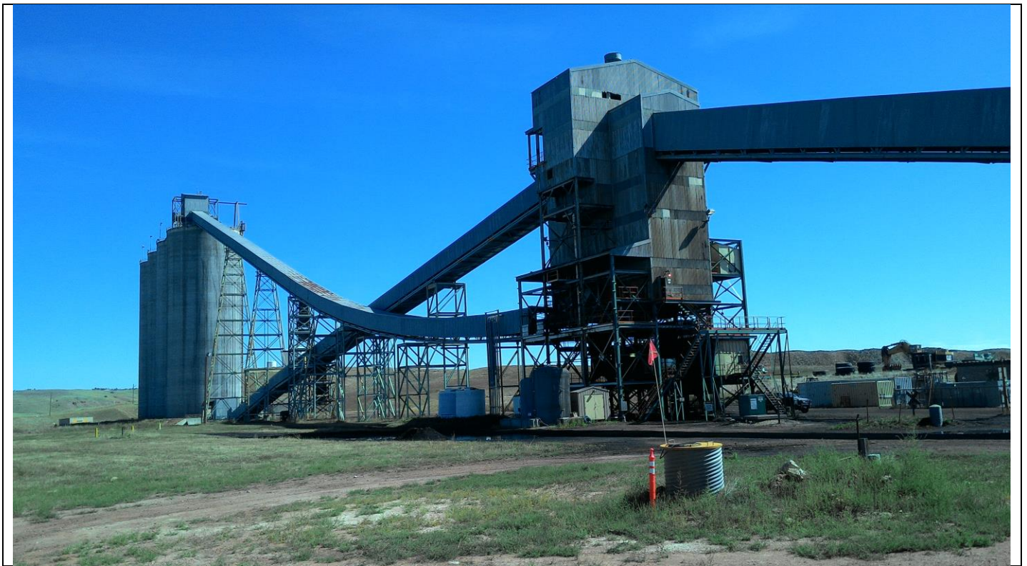
圖4-8：Decker煤礦CHPP區域火車裝煤設備及筒倉
