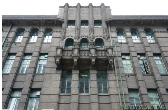
照 48 京都市役所側門
