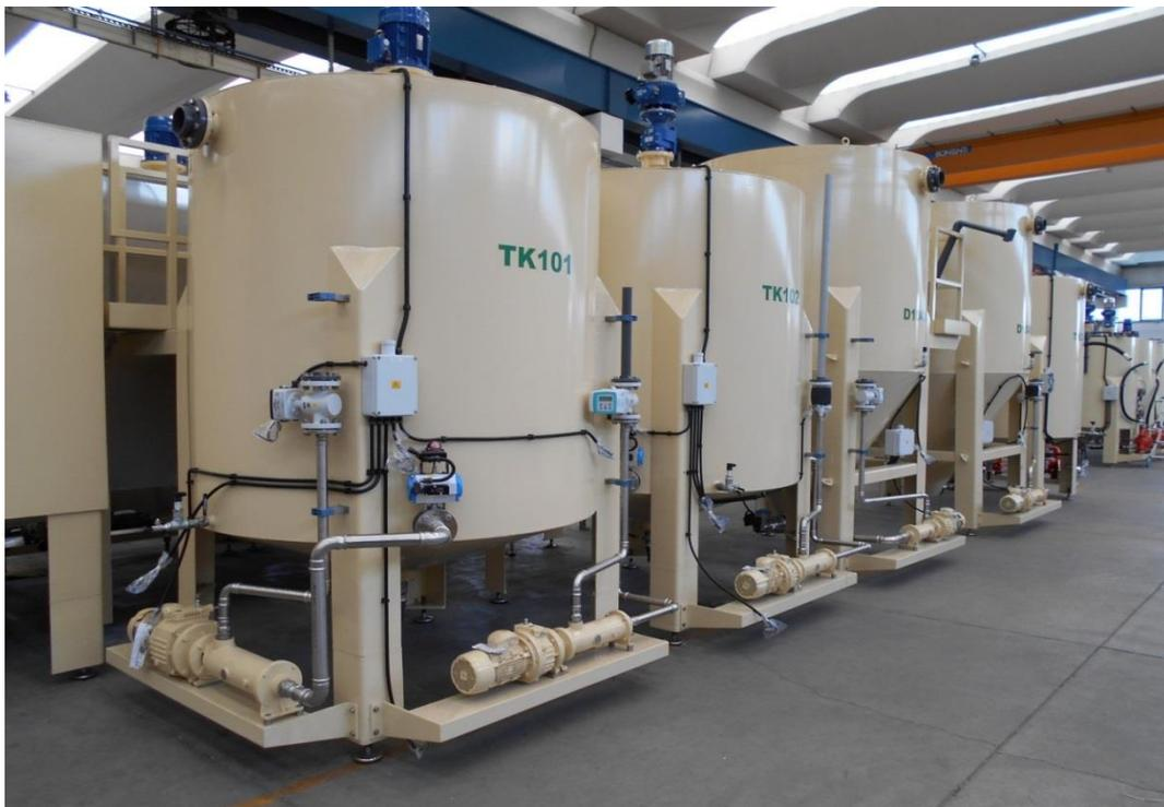
圖十八、Aqua Save II DEC 凹版印刷廢水收集槽
