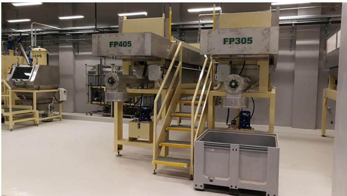
圖十六、Aqua Save II DEC 濃縮槽污泥板框壓濾機
