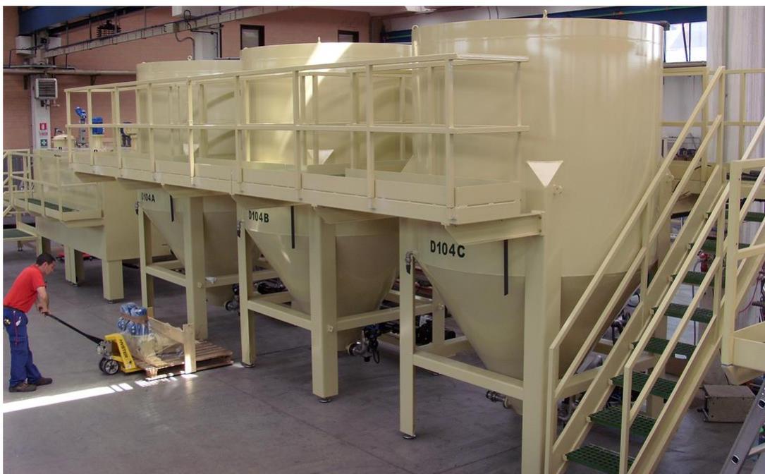
圖十九、Aqua Save II DEC 靜態傾析器外觀
