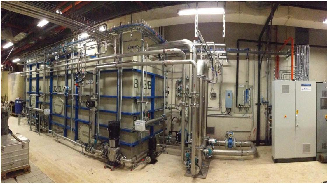
圖五、超過濾回收系統（一）
