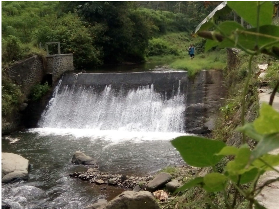
圖 3 Dam Pandansari 供水計畫攔河堰之河川水景象
