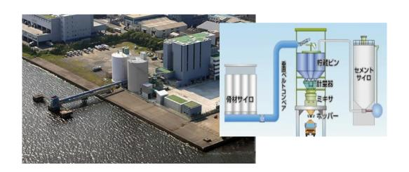
圖 17: 晴海小野田混凝土製造廠
