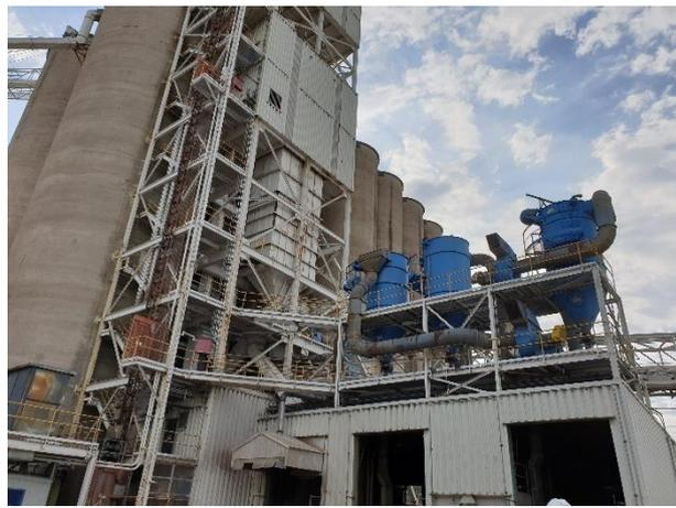
圖 48. 穀倉作業以升降梯系統將穀物帶到頂端再按設定的門閥通道進入穀倉中。
