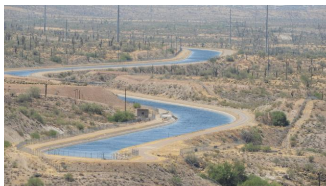
圖 60. CAP 輸水渠道
