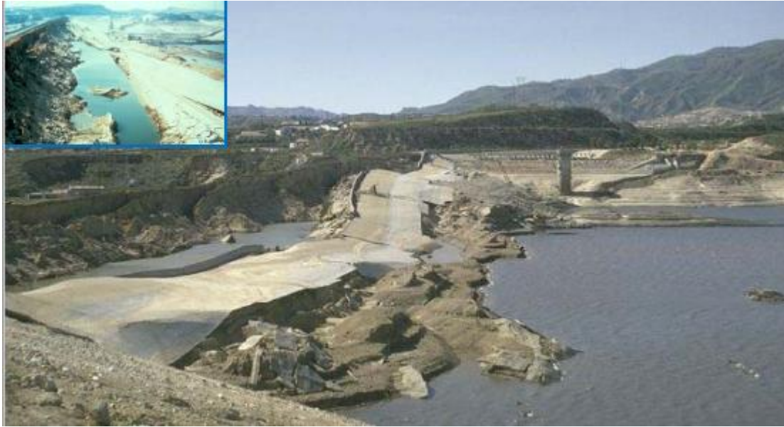
圖 24. Lower San Fernando 壩因地震誘發液化造成損壞
