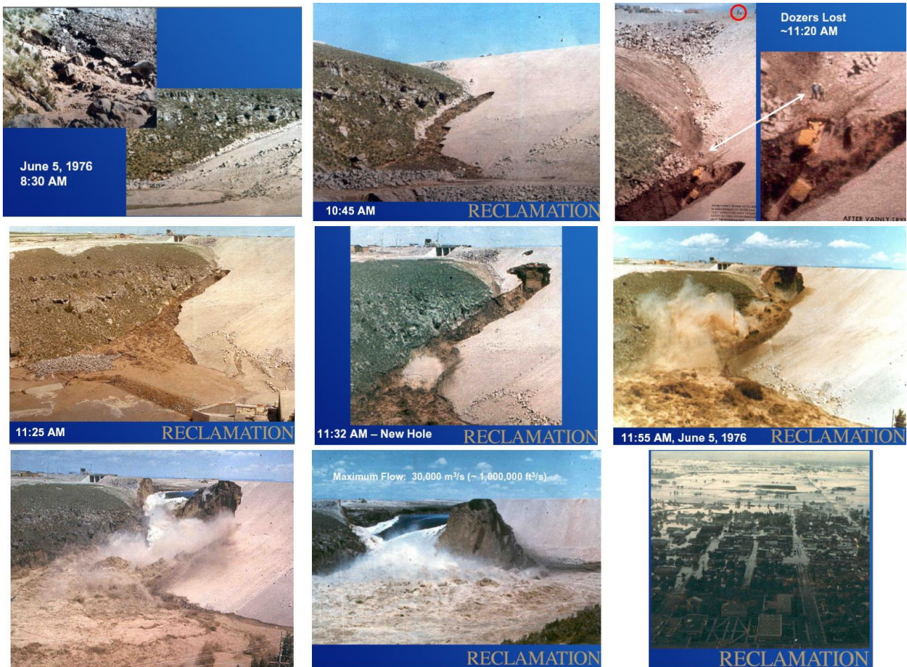
圖 21. Teton 壩從 08:30~11:55 潰壩過程及下游淹水情形
