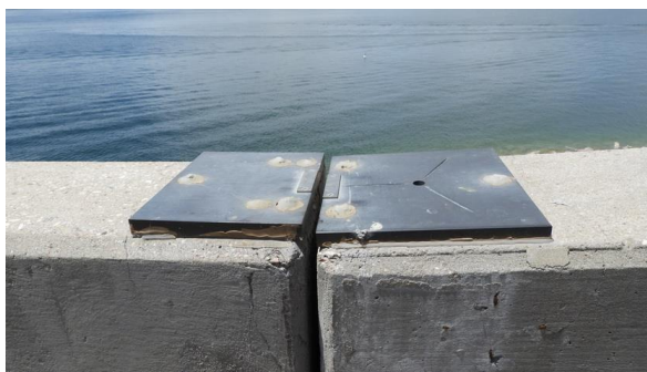
圖 51.混凝土壩護欄變位觀測
