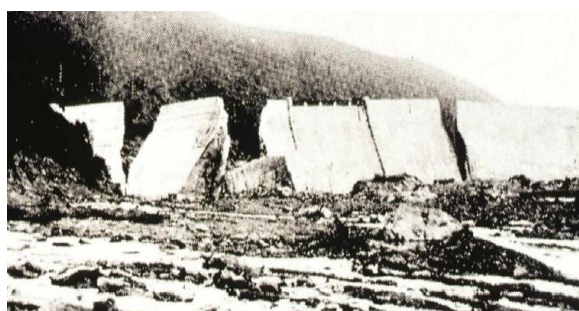
圖 10. Austin 壩 1911 年損壞(甫完工 2 年，80 人死亡)。
