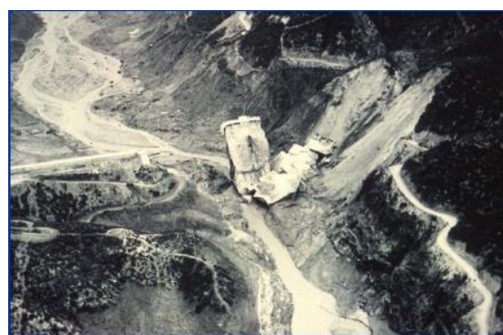
圖 11. St. Francis 壩 1928 年損壞。(450 人死亡)
