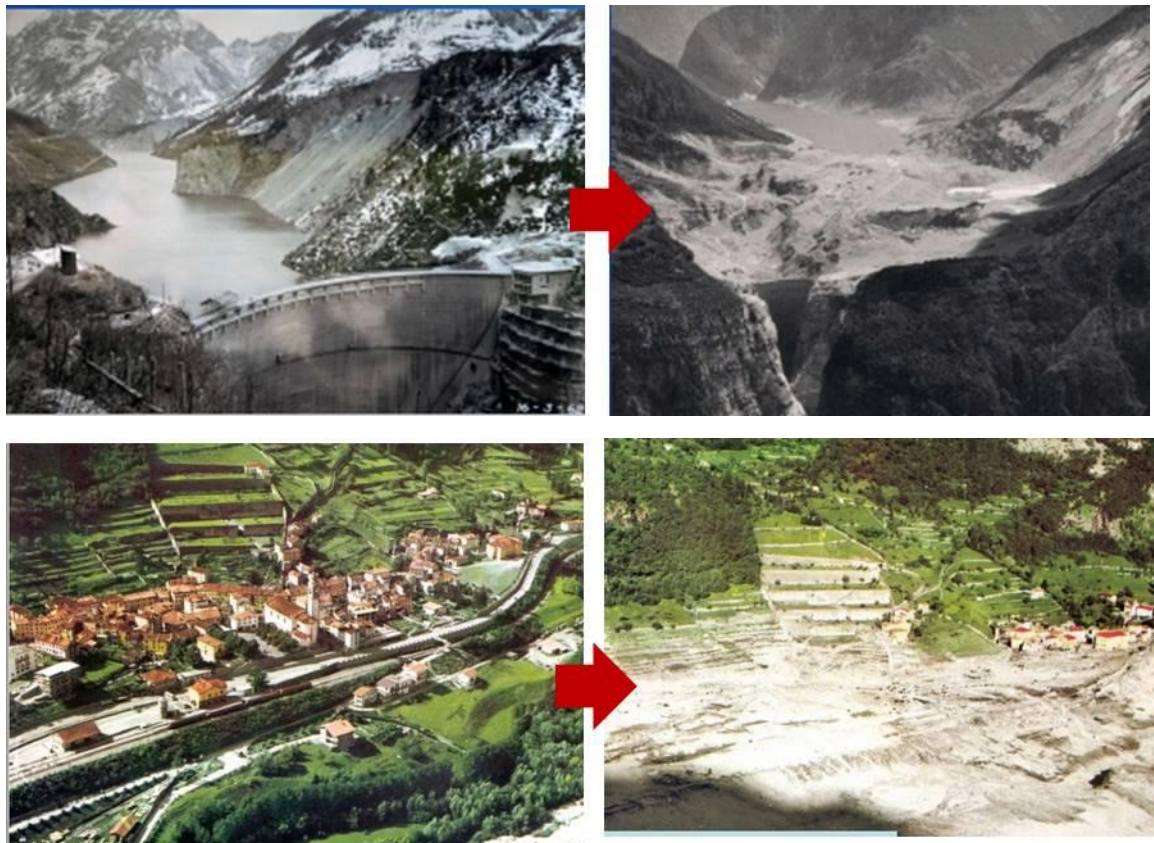
圖 23. Vaiont 壩因邊坡滑動，造成庫區湧浪越過大壩沖毀下游社區
