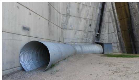
圖 52.檢查廊道入口(鐵皮為防止冬季時壩上方冰柱掉落傷人，廊道內禁止拍照)
