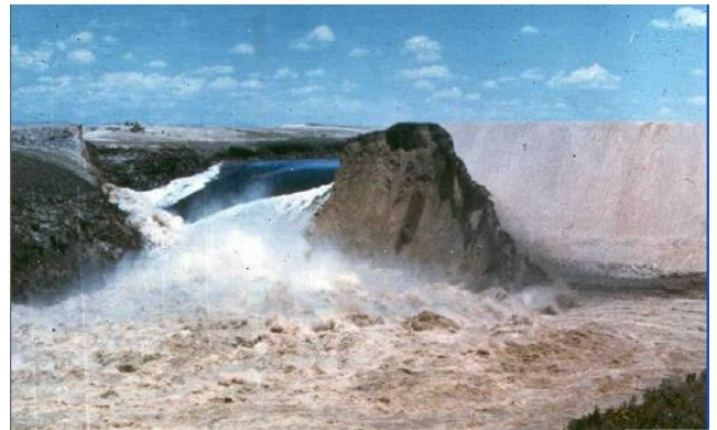
圖 15. Teton Dam 壩 1976 年損壞(11 人死亡)。
