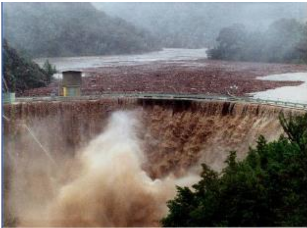
圖 33. San Clemente 壩壩前漂流木
