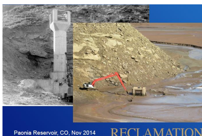
圖 31. Paonia 水庫取水口淤積前後比較
