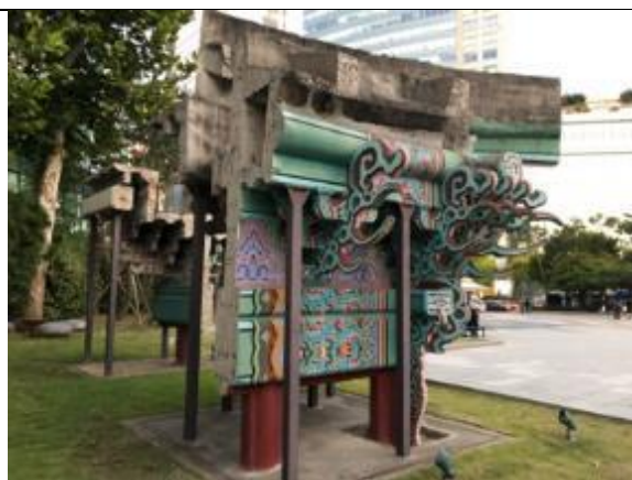
光化門鋼筋混凝土結構部件。
