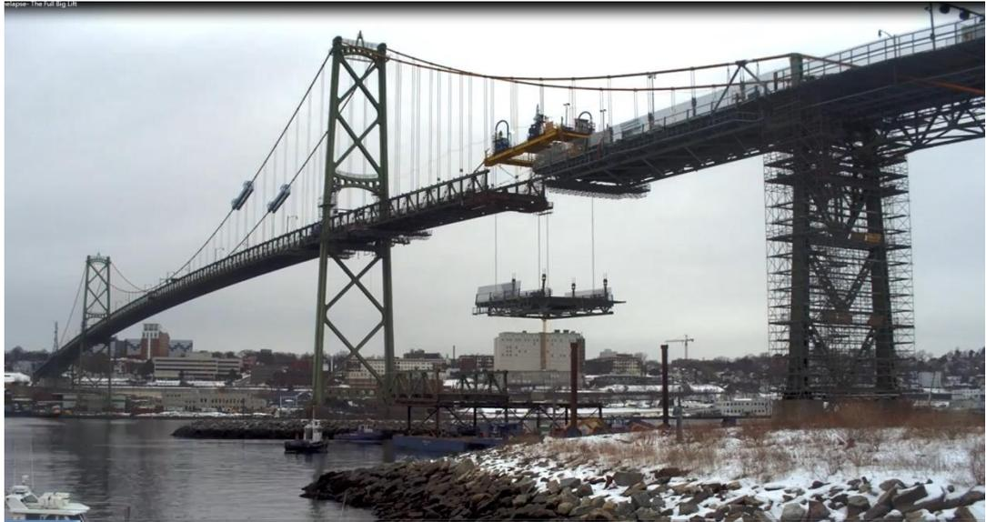
圖 22 預鑄完成之新橋面自橋下駁船吊升銜接照片(摘自 HHB 簡報)
