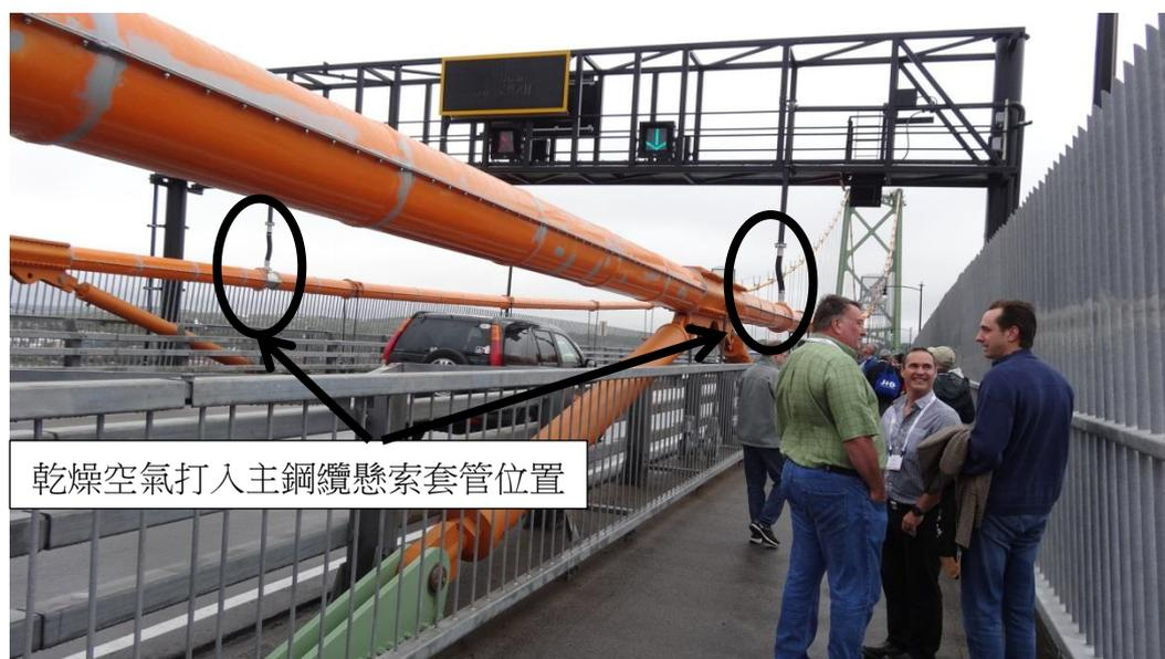
圖 8 Macdonald Bridge 主鋼纜乾燥空氣打入主鋼纜懸索套管位置照片
