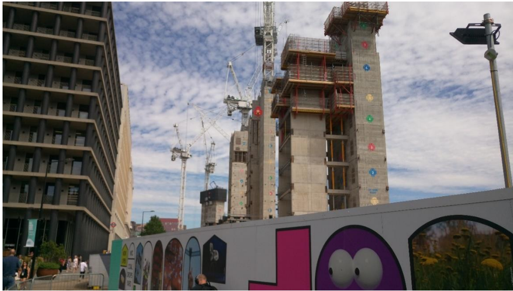
圖 15：Google 公司位於倫敦分部及一旁正在新建的 Google 大樓照片
