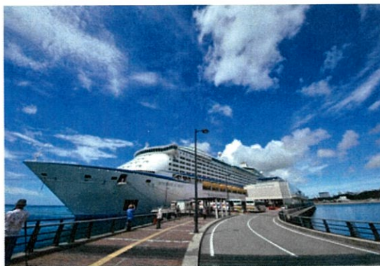
圖 15 那霸港郵輪客運站
