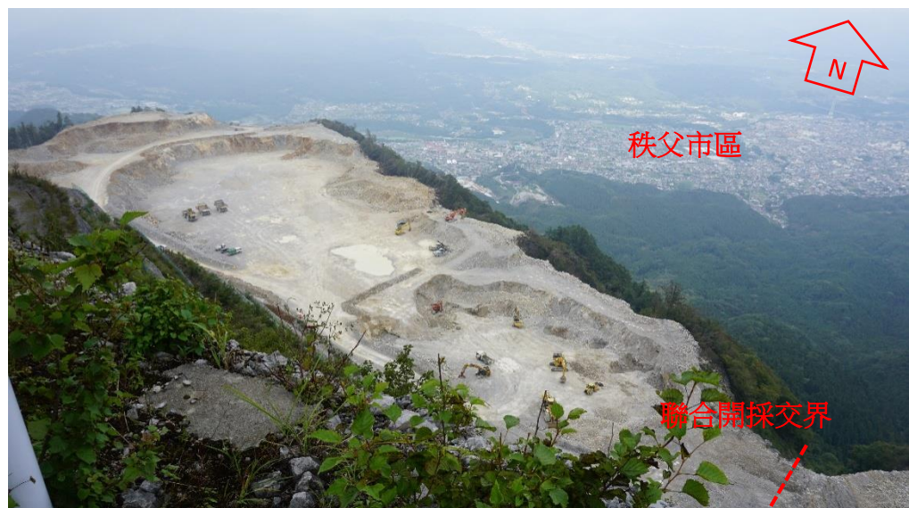
圖 3.3.2 三輪礦場海拔 900 公尺階段面之俯瞰圖
