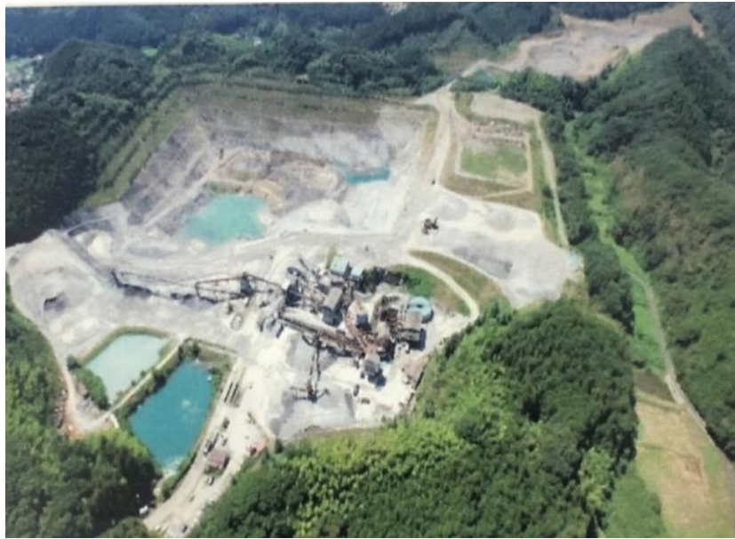
圖 3.5.2 坡地（陸砂）開採及回填作業
