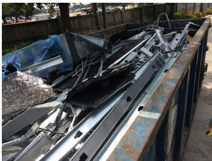
圖 10.建築廢棄金屬儲存箱體
