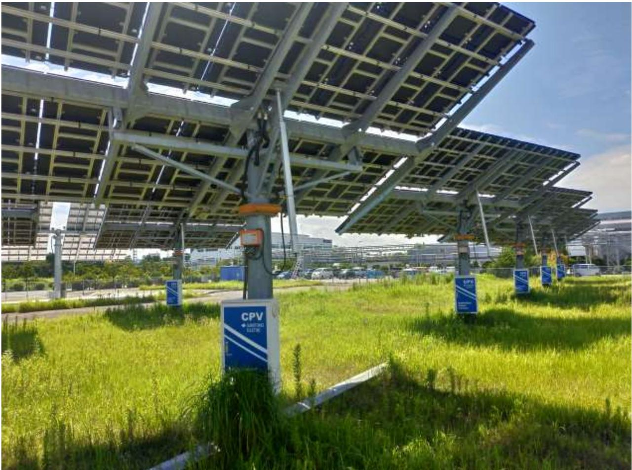
圖 17、聚光型態太陽能發電系統實拍。
