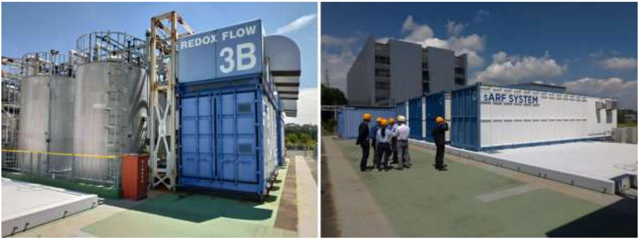
圖 16、住友電工第一代(左)及第二代(右)鈇液流電池設備實拍。
