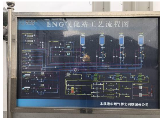
圖十五:氣化站流程圖
