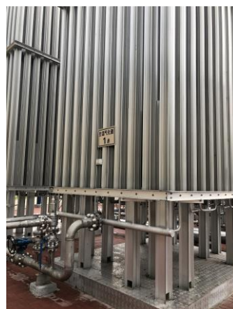
圖二十五空溫氣化器
