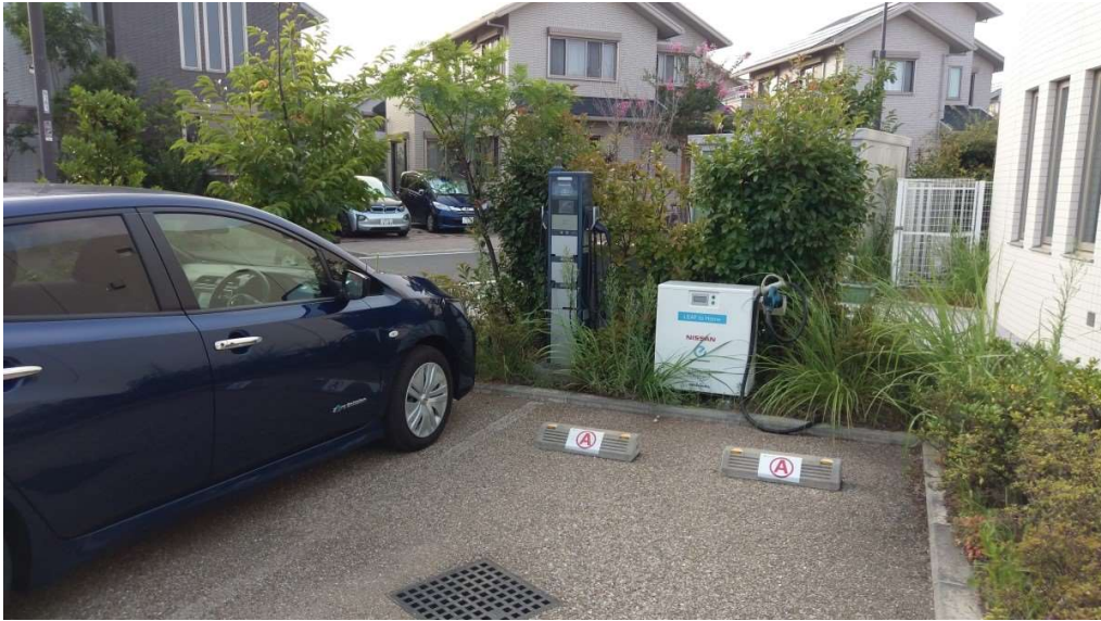
圖 13、V2G 與平時電動車充電使用兩套設備
