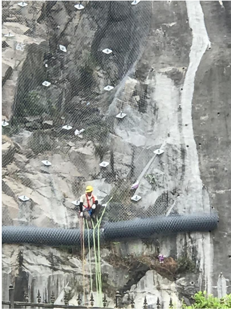
圖 10 澳門氹仔邊坡作業情形
