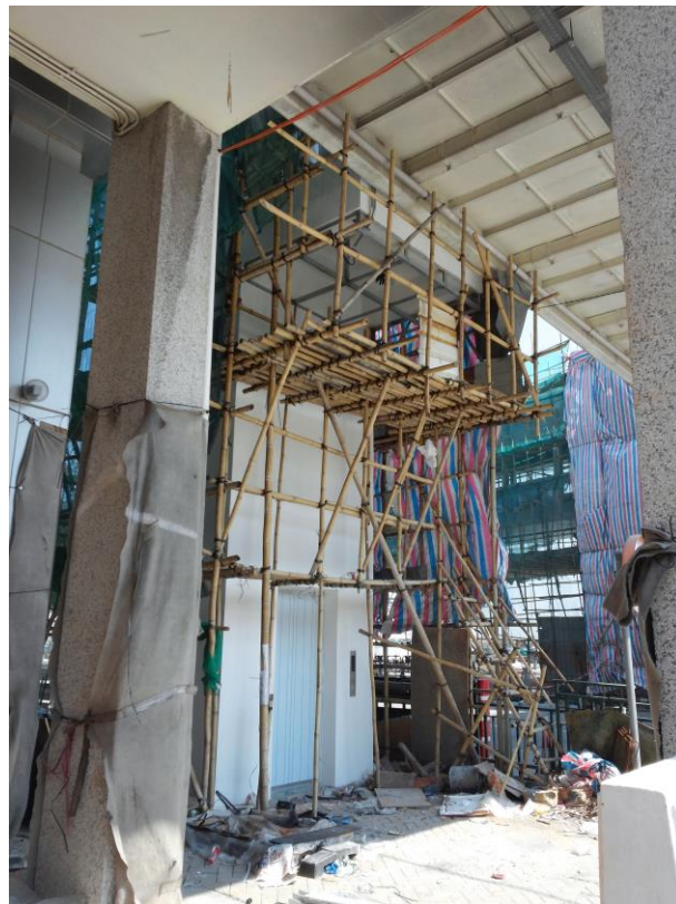
圖 13 澳門市天橋維修以竹子搭設上下設備及平台的情形
