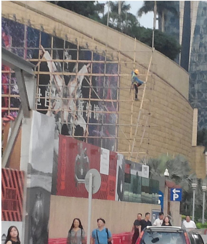
圖 11 新濠天地看板竹架搭設的情形
