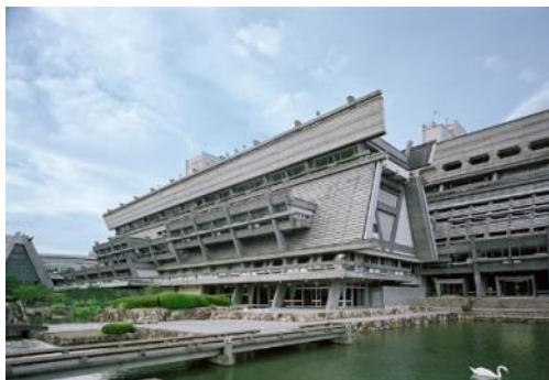
▲ 正梯形與倒梯形上下共構的建築造型 5
