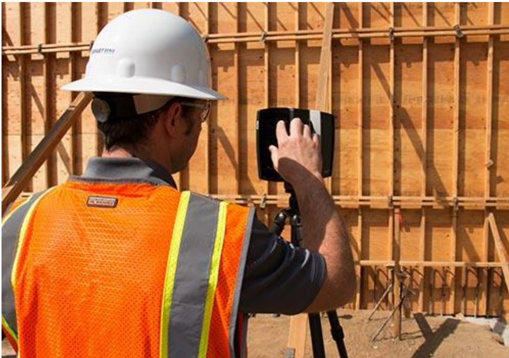
圖表 26 工地現場捕捉數據資料（來源：FARO 官網）
