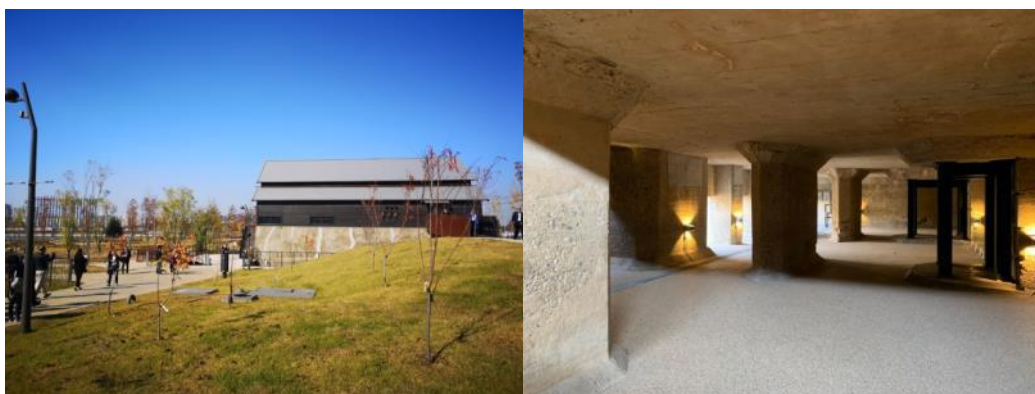
圖九、陽川抽水站內部及外部照片
