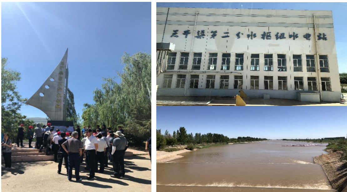
圖 27、內蒙古河灌區總幹渠第二樞紐及水電站
