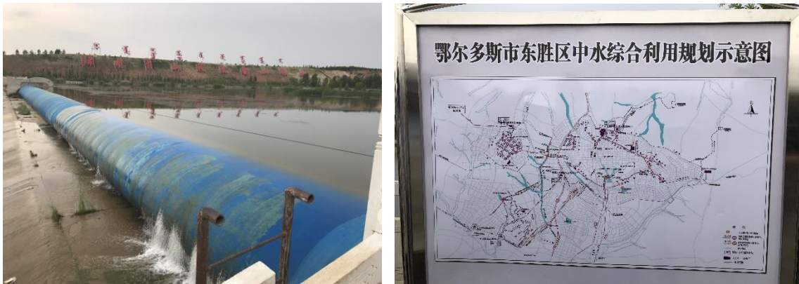
圖 8、吉勞慶川沿線布設大型橡皮壩攔蓄水及中水綜合利用規劃示意圖
