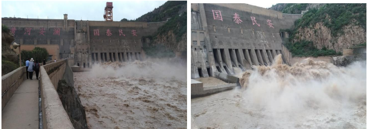
圖 33、三峽水庫進行底孔排砂
