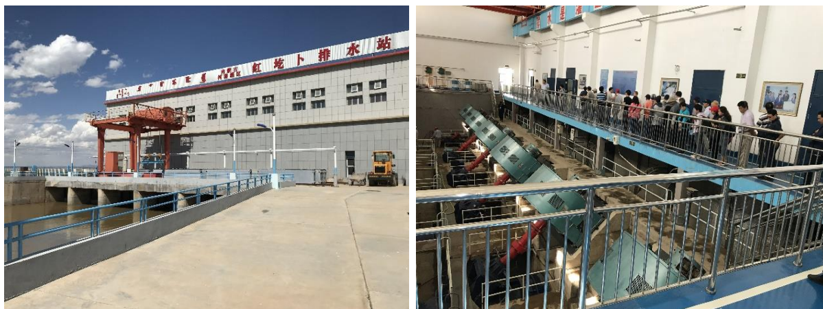
圖 30、紅坨卜排水站及斜式軸流泵
