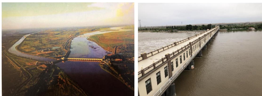
圖 12、空拍三盛公及黃河流經三盛公攔河閘全貌
