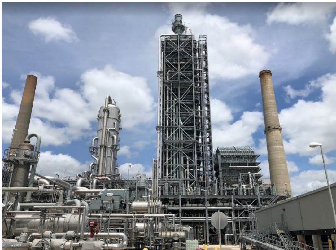
圖 12、德州 Petra Nova 二氧化碳吸收塔及吸收劑再生塔
