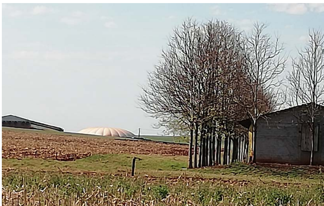
圖 2-10 養豬戶建置之大型覆蓋式厭氣消化槽(白色罩)
