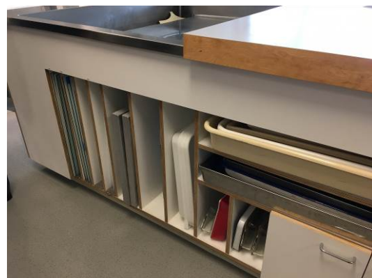
水槽下的空間運用，依據各種清洗用具設計隔層，使水盆工具便於拿取，亦可分類存放妥當。
