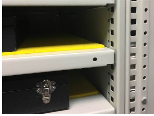
博物館庫房內傾斜式層架與鋪設 PE 墊防震
