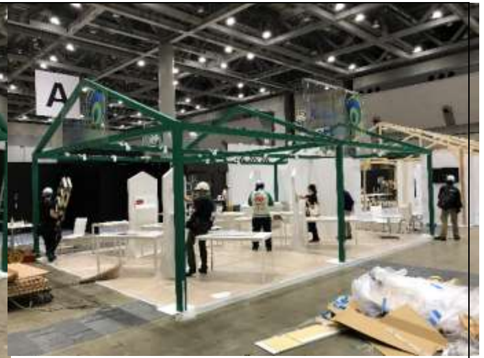
委辦廠商進行展場施工 2
