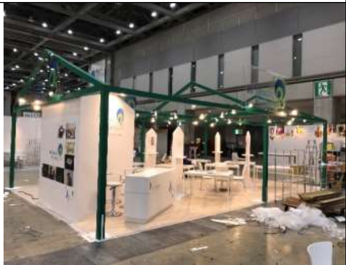
委辦廠商進行展場施工 3
