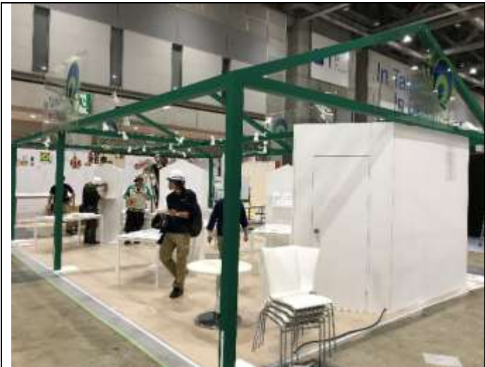
委辦廠商進行展場施工 1
