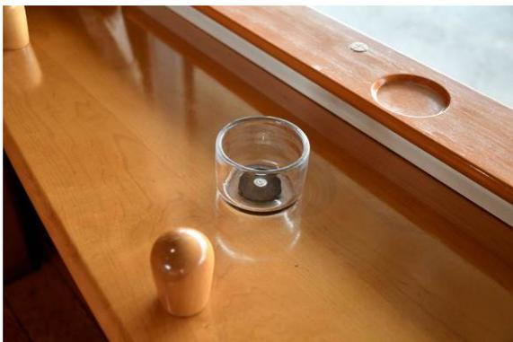
圖 42 「特急坐 A 列車去吧」可供玻璃杯放置的凹槽及固定座
