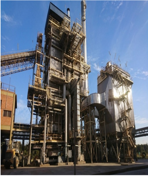
生產蒸氣鍋爐
