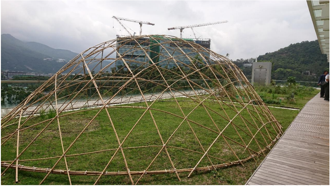
香港中文大學廢棄物再生利用屋頂植栽降低空調用電
