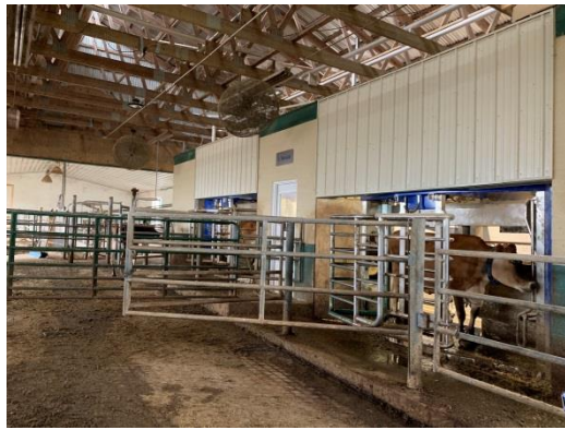
圖 1. Shenandoah Jersey's 牧場兩組不同進出方向之 Delaval 機器人擠乳機
