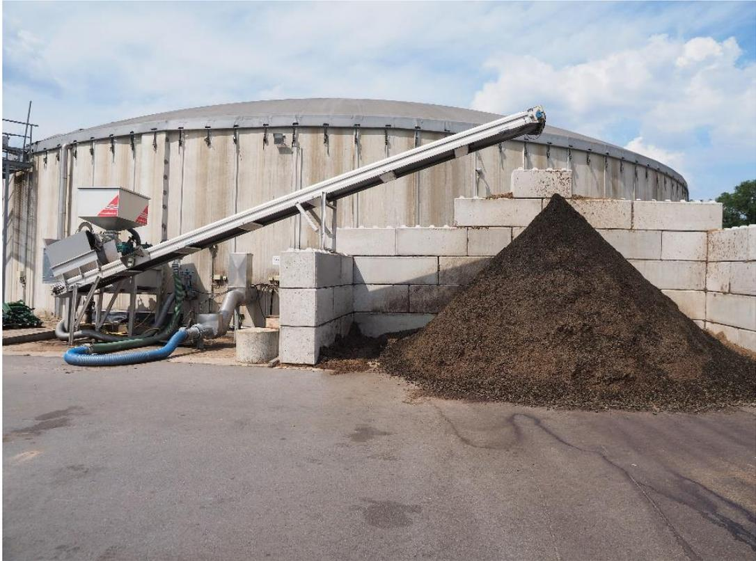
圖 11、沼液沼渣固液分離機與分離後之沼渣
