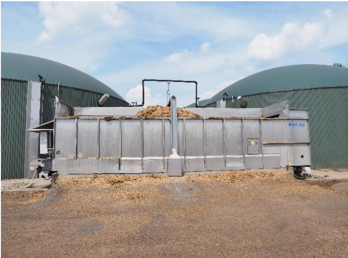
圖 6、廠外共消化物進料混合槽
