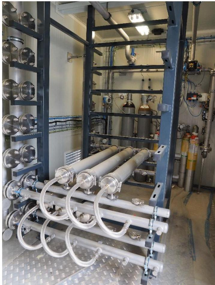
圖 20、沼氣純化裝置與即時濃度監控設備
