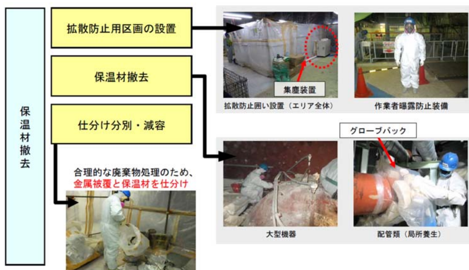
圖二十一 拆除保溫材使用的集塵裝置示意圖
