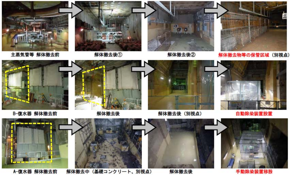
圖二十八 汽機廠房之主蒸氣管路、冷凝器拆解前後與手動/自動除污裝置、保管區域設置
