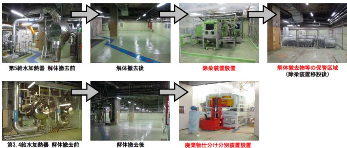
圖二十七 汽機廠房之飼水加熱器拆解前後與除污、分類、保管區域設置
