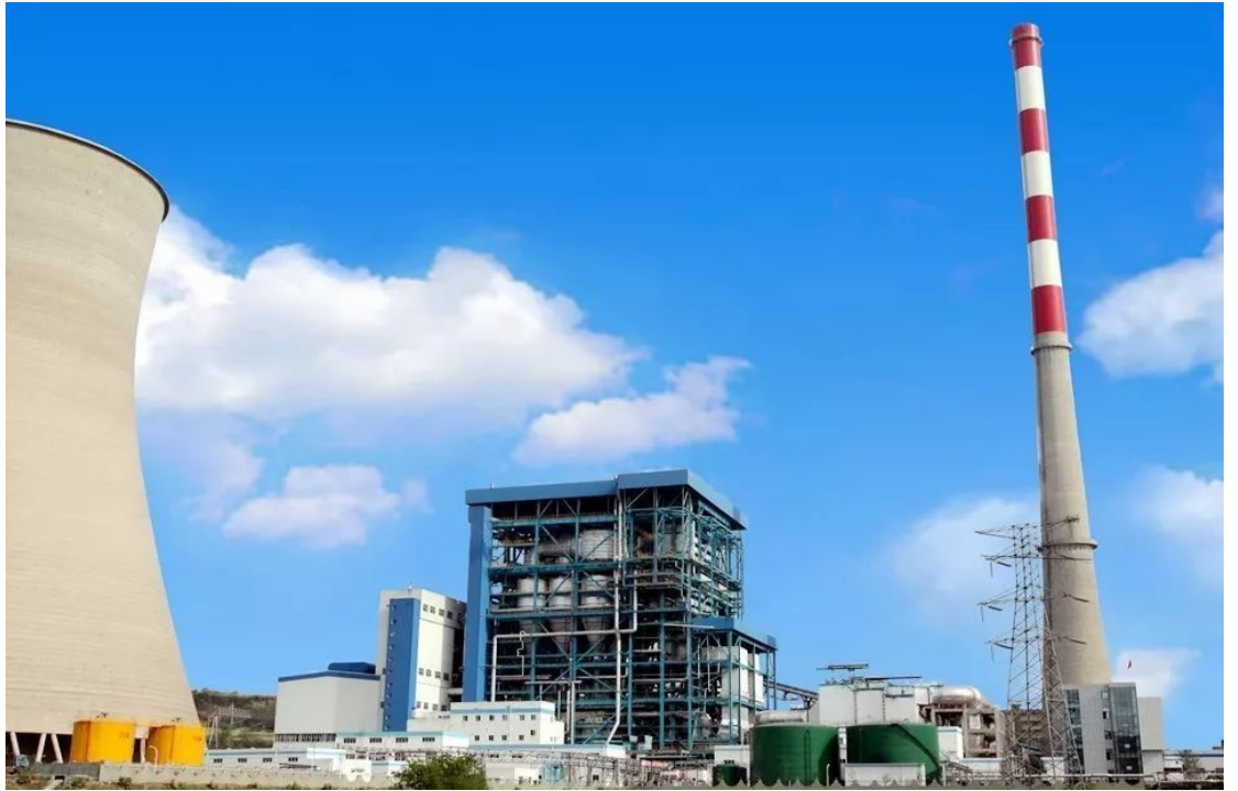
圖 17. 四川白馬 600MW 超極限循環流體化床發電機組
