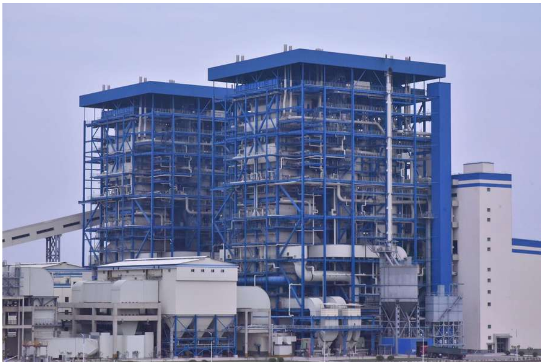
圖 18. 徐州華美兩座 350MW 超極限循環流體化床發電機組
