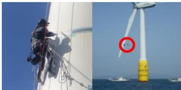
圖2-3 風力發電設備與葉片維修和檢查工作照
